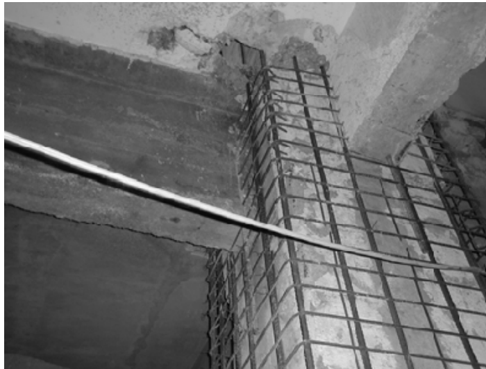
Σχήμα 6.3: Μανδύας στην περιοχή κόμβου δοκού - υποστυλώματος
