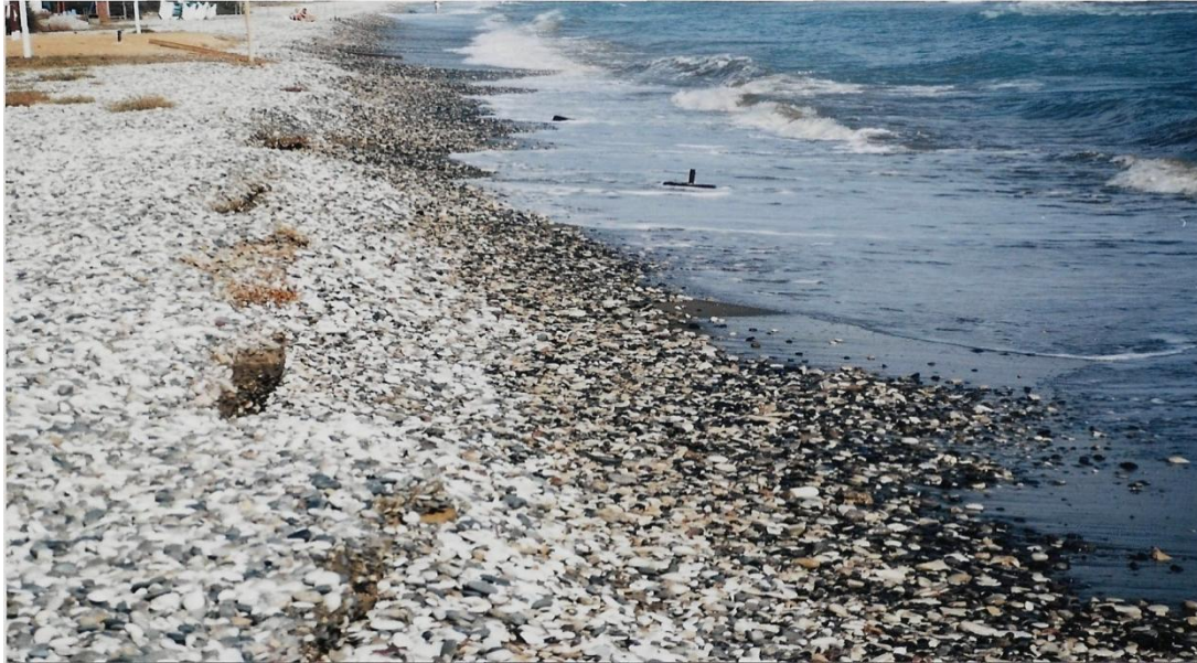
Φωτογραφία 3.2 – Διάβρωση δυτικού τμήματος
