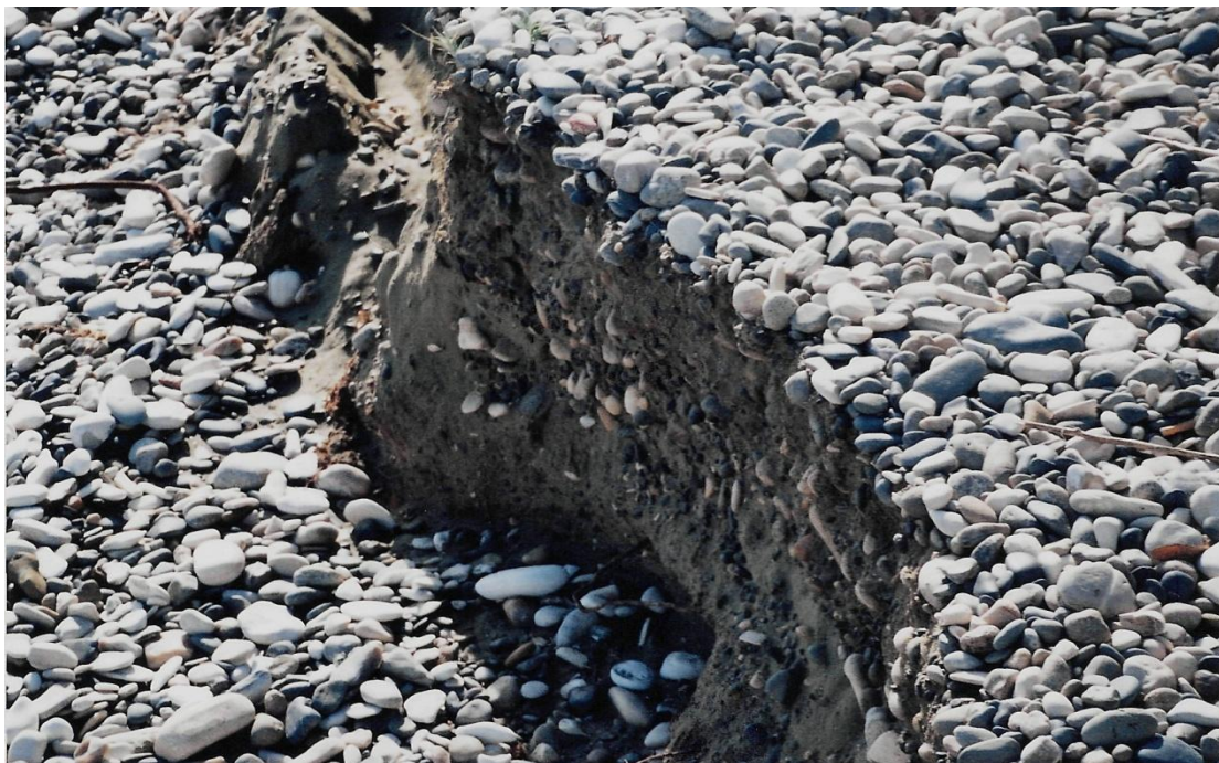
Φωτογραφία 3.3 – Διάβρωση δυτικού τμήματος
