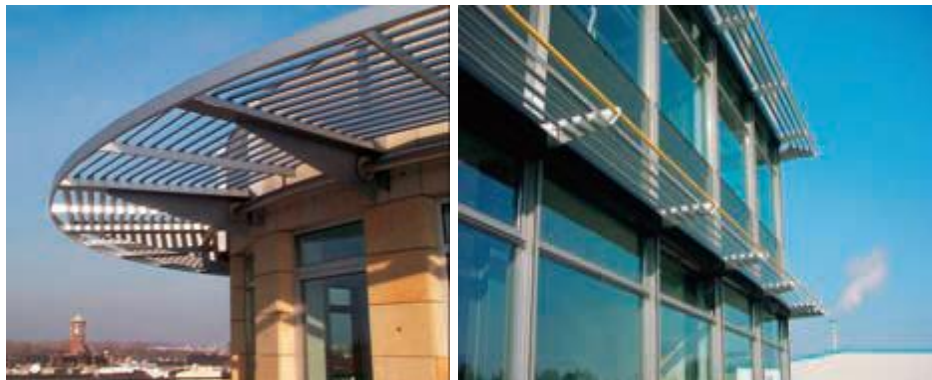
Εικόνα 7.4. Σταθερά συστήματα σκίασης (Οριζόντιοι πρόβολοι)
