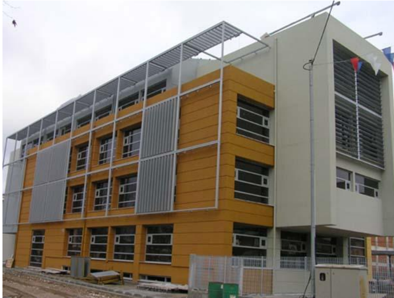
Εικόνα 7.8. Δημαρχείο Δράμας. Στην Ανατολική και Δυτική πλευρά τοποθετήθηκαν πλαίσια με κατακόρυφες κινητές περσίδες. Ενώ για την Νότια πλευρά που έπρεπε να αντιμετωπιστεί η χαμηλή ηλιοφάνεια όλη την ημέρα χρησιμοποιήθηκε το ίδιο σύστημα αλλά σε οριζόντια τοποθέτηση.
