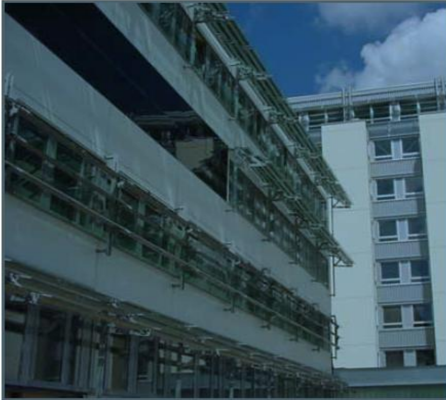
Εικόνα 7.10. Εξωτερικές περσίδες με φωτοβολταϊκά στοιχεία
