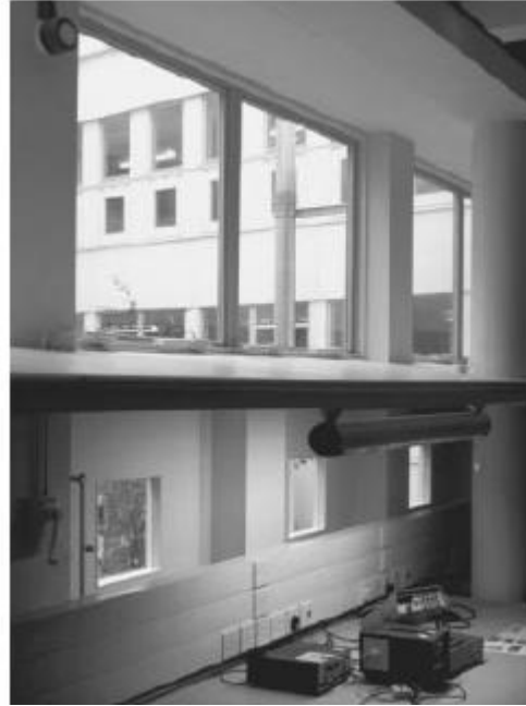
Εικόνα 6.2. Ετερογενής σχεδιασμός παραθύρων: διαφορετικά συστήματα μπορούν να εφαρμοστούν σε διαφορετικά σημεία του παραθύρου ή παρόμοια συστήματα μπορούν να λειτουργούν ξεχωριστά σε διαφορετικά σημεία του παραθύρου.
