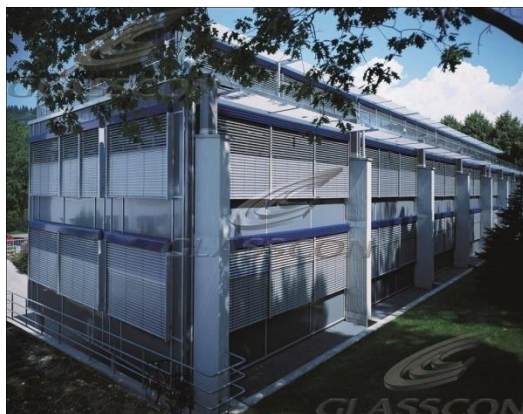
Εικόνα 7.9. Εξωτερικές ηλεκτρικές περιστρεφόμενες περσίδες αλουμινίου
