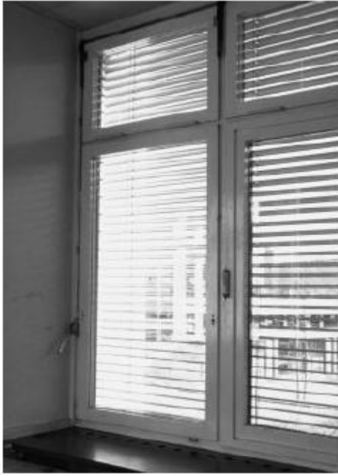
Εικόνα 6.2. Ετερογενής σχεδιασμός παραθύρων: διαφορετικά συστήματα μπορούν να εφαρμοστούν σε διαφορετικά σημεία του παραθύρου ή παρόμοια συστήματα μπορούν να λειτουργούν ξεχωριστά σε διαφορετικά σημεία του παραθύρου.
