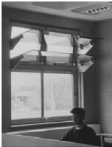
Διπλά ημιδιαφανή ανακλαστικά ράφια φυσικού φωτισμού από ανακλαστικό γυαλί.
