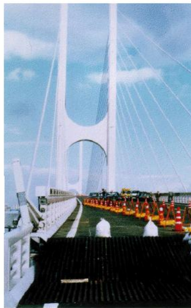
Εικόνα 1.8 : Ανασήκωμα του καταστρώματος της γέφυρας Higashi – Kobe μετά το σεισμό του Kobe (1996)
