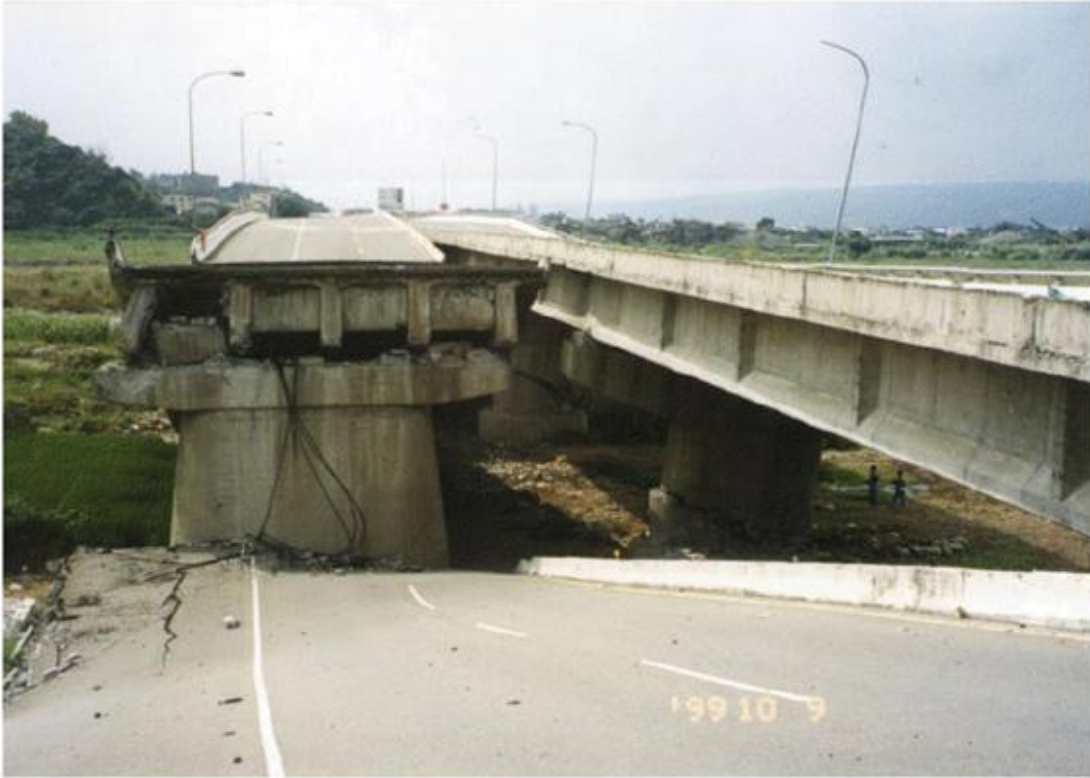
Εικόνα 1.5: Κατάρρευση της γέφυρας Wu – Shi από το σεισμό του Chi – Chi (Taiwan 1999)
