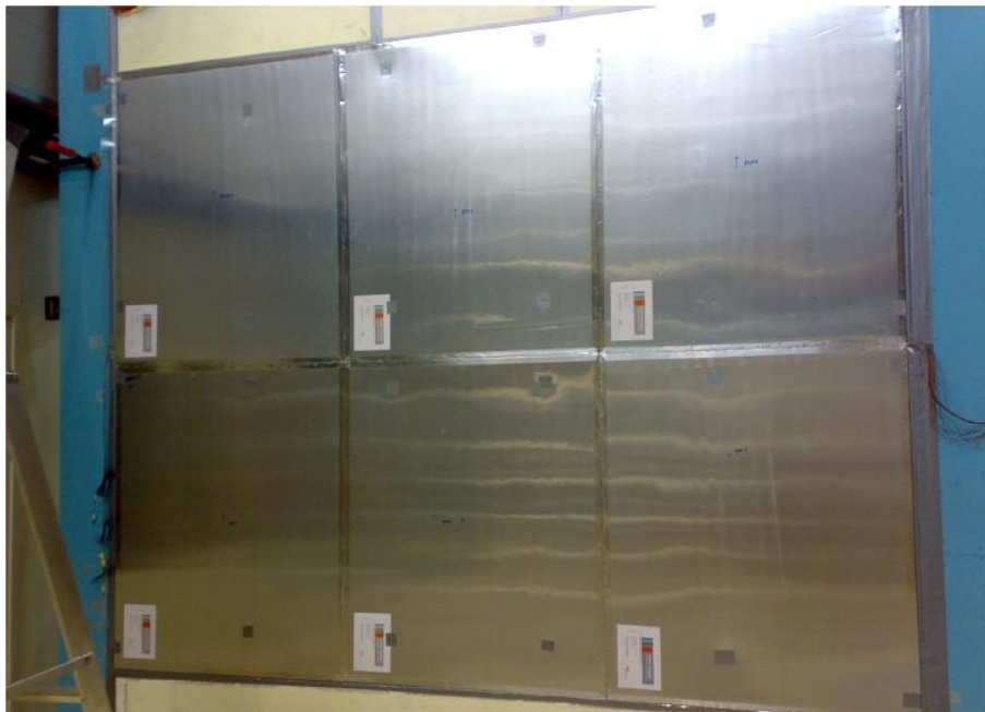
Σχήμα 2.1.13: Φωτογραφία πειραματικού τοίχου επενδεδυμένου με Dupont™ Energain® PCM πάνελς.[42]
