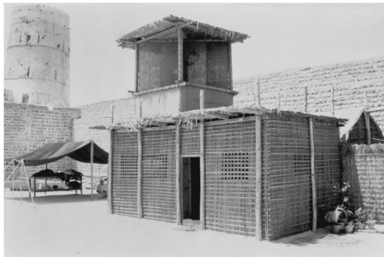
Σχήμα 1.1.2: Απεικόνιση ανακατασκευασμένης ιστορικής κατοικίας στο Dubai.-Οι δίοδοι αέρα (ανοίγματα στην επένδυση) του κτιρίου επιτρέπουν τον φυσικό αερισμό του. [1]
