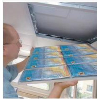
Σχήμα 2.1.7: Εφαρμογή PCMs (Dorkins DELTA®-COOL 24) σε σακουλάκια με αλουμινένιο περίβλημα [31].
