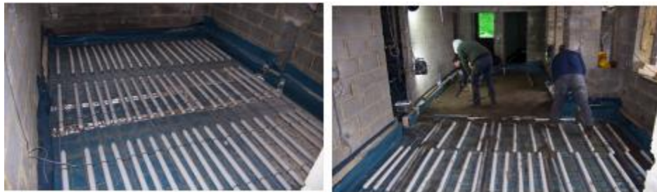
Σχήμα 2.1.24: Εγκατάσταση ενδοδαπέδιου PCM συστήματος θέρμανσης της εταιρείας PCM products [59].
