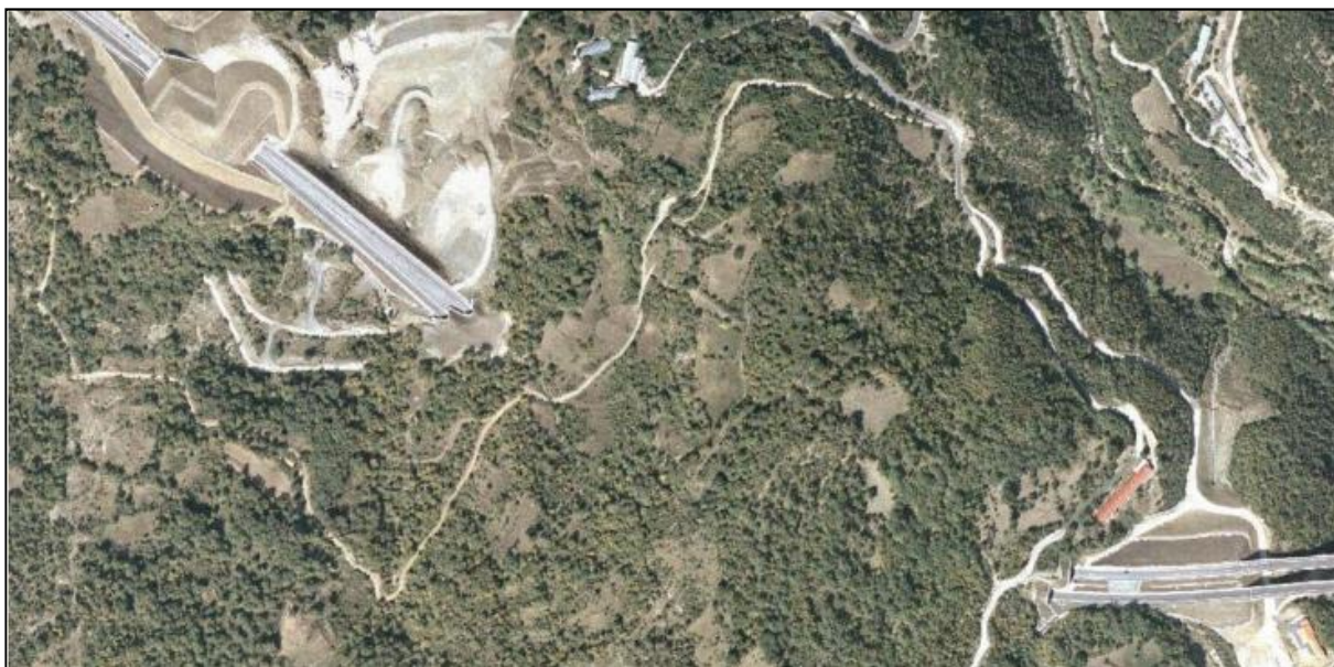
Σχήμα 4.1 Αεροφωτογραφία της περιοχής της σήραγγας Ανθοχωρίου (Πηγή: Ιστότοπος www.ktimatologio.gr , Περίοδος φωτοληψίας 2007-2009)
