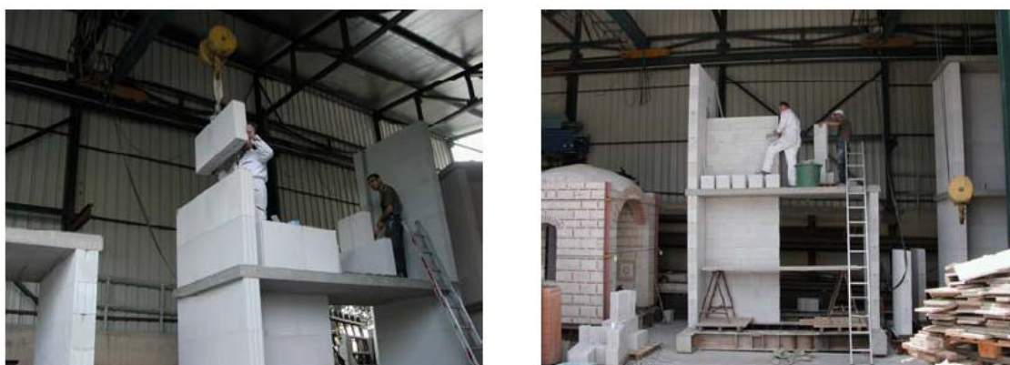
Φάση κατασκευής των εξεταζόμενων δειγμάτων (εικόνα 1.8)
