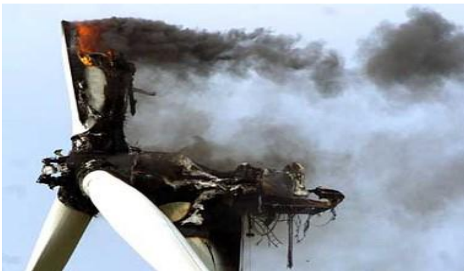
Εικόνα 10: Κατεστραμμένη Ανεμογεννήτρια λόγω «κόπωσης» από την παρατεταμένη χρήση σε ισχυρό αιολικό δυναμικό (8)
