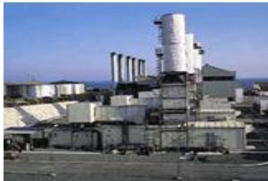
Εικόνα 7: Ηλεκτροπαραγωγικός σταθμός Μονής(3)
