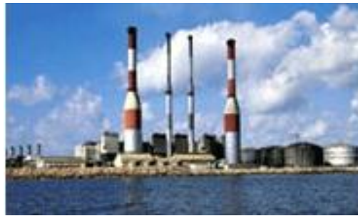
Εικόνα 6: Ηλεκτροπαραγωγικός σταθμός Δεκέλειας(3)
