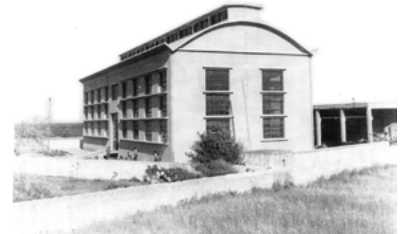
Το κτίριο στην αρχική του μορφή.
