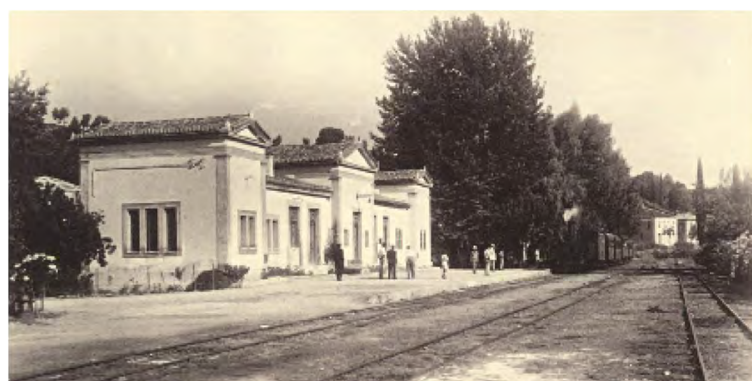
Το αρχαιοπρεπές οικοδόμημα του σταθμού της Αρχαίας Ολυμπίας Πηγή: “Οι ελληνικοί σιδηρόδρομοι: η διαδρομή τους από το 1869 έως σήμερα”, Σύλλογος Φίλων του Σιδηροδρόμου, εκδ. Μίλητος
