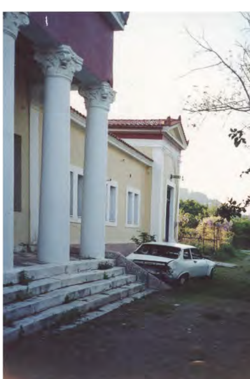
Εικόνα εγκατάλειψης από το Σιδηροδρομικό σταθμό Αρχαίας Ολυμπίας (2002) Πηγή: αρχείο Α. Φιλippουπολιτή
