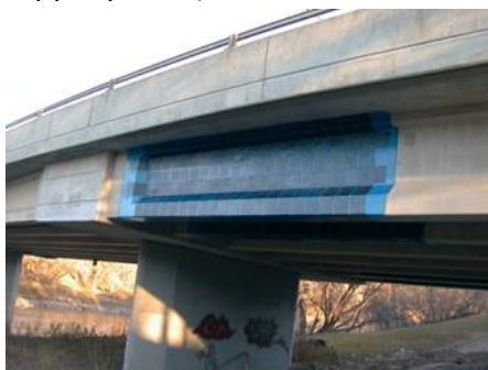
Εικόνα 13. Επισκευή γέφυρας με ανθρακονήματα
