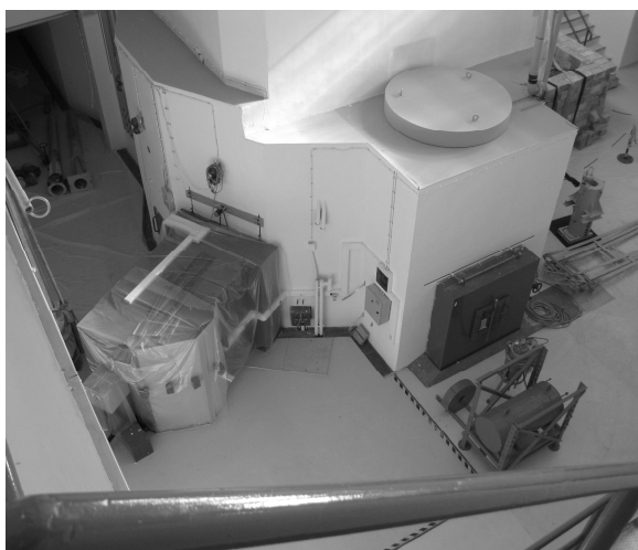
Σχήμα 3.3 Απόψεις της θερμικής στήλης του αντιδραστήρα GRR-1 και των θυρών οριζόντιας και κάθετης πρόσβασης στη θέση ακτινοβόλησης
