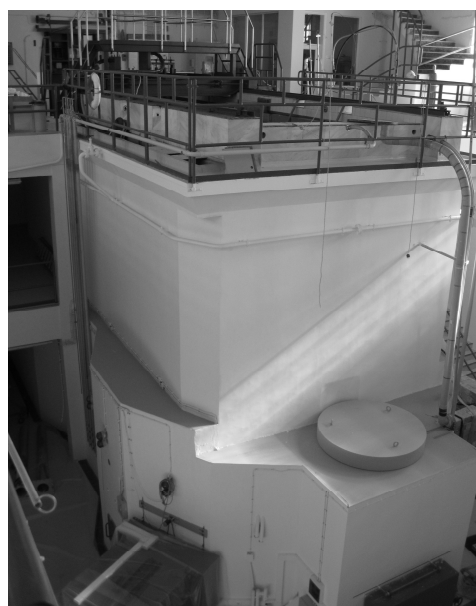
Σχήμα 3.3 Απόψεις της θερμικής στήλης του αντιδραστήρα GRR-1 και των θυρών οριζόντιας και κάθετης πρόσβασης στη θέση ακτινοβόλησης
