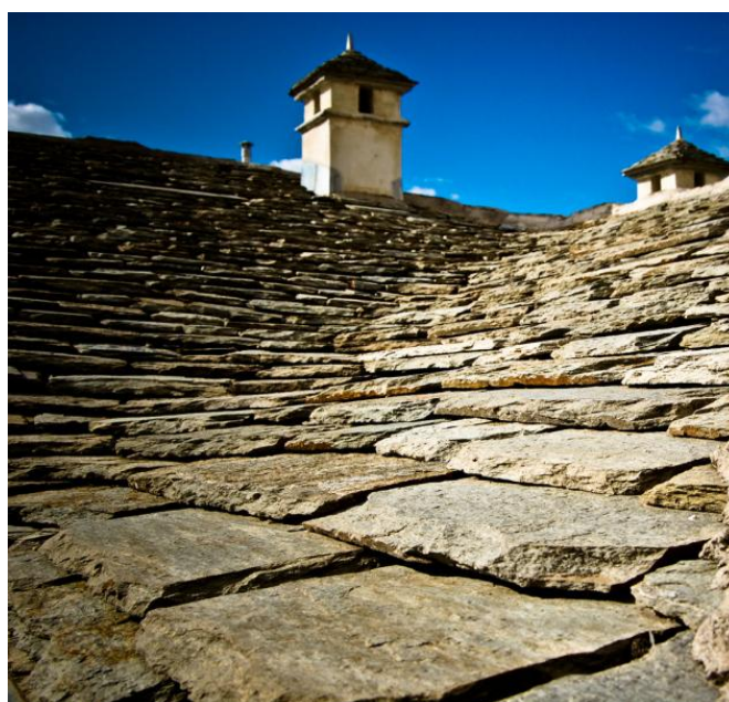
Εικόνα 88 Παραδοσιακή πηλιορείτικη στέγη με επικάλυψη από σχιστόπλακες
