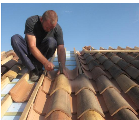
Εικόνα 78 Διαδικασία τοποθέτησης κοίλων κεραμιδιών. Τοποθέτηση πρώτα των στρωτήρων και στη συνέχεια των καλυπτήρων.
