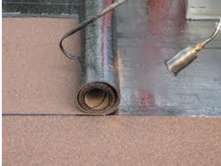
Εικόνα 54 Τοποθέτηση ασφαλτόπανου με φλόγιστρο ( www.monosimacon.blogspot.gr )
