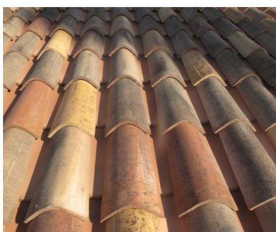
Εικόνα 78 Διαδικασία τοποθέτησης κοίλων κεραμιδιών. Τοποθέτηση πρώτα των στρωτήρων και στη συνέχεια των καλυπτήρων.
