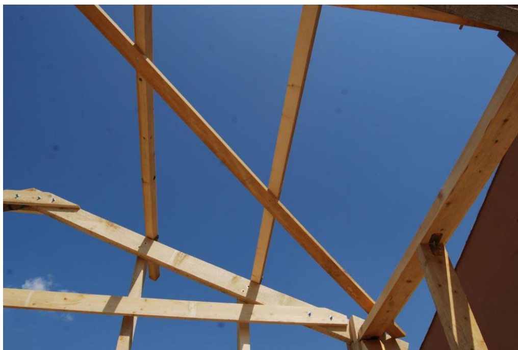
Εικόνα 14 Αντιανέμια σε φορέα στέγης χωρίς μεσαίο ορθοστάτη
