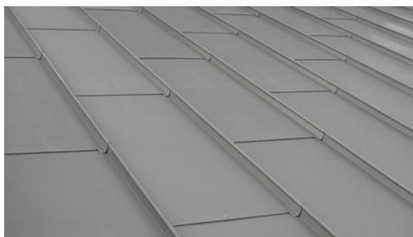
Εικόνα 103 Στέγη επικαλυμμένη με πλάκες τιτανιούχου ψευδάργυρου www.euroclad.com
