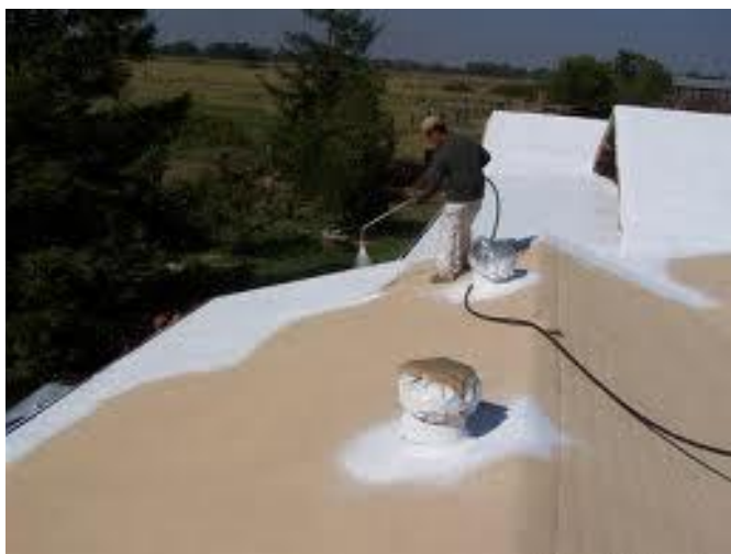
Εικόνα 65 Τοποθέτηση πολυουρεθάνης με ψεκασμό (www.monosimacon.blogspot.com)
