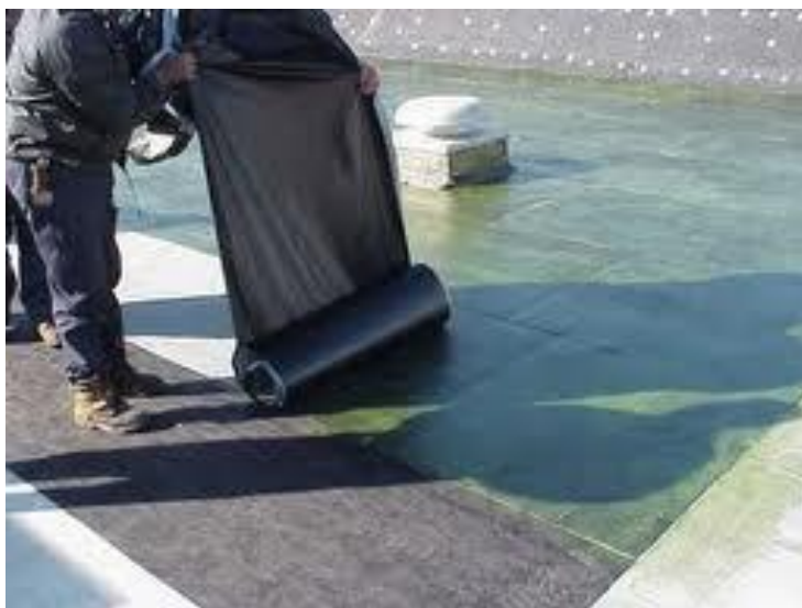
Εικόνα 56 Εργασίες τοποθέτησης μεμβράνης PVC
