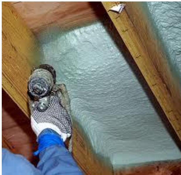
Εικόνα 64 Τοποθέτηση αφρού πολυουρεθάνης
