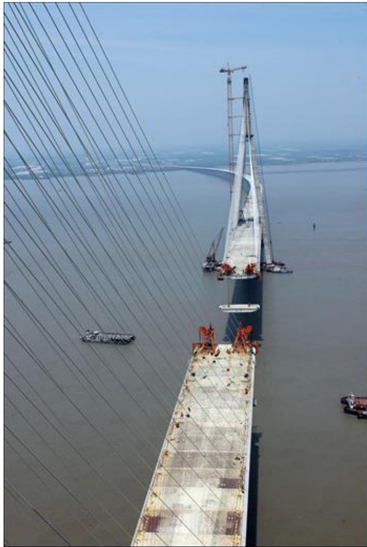
Εικόνα 3- 3 Η ένωση του καταστρώματος στο κεντρικό άνοιγμα (58)
