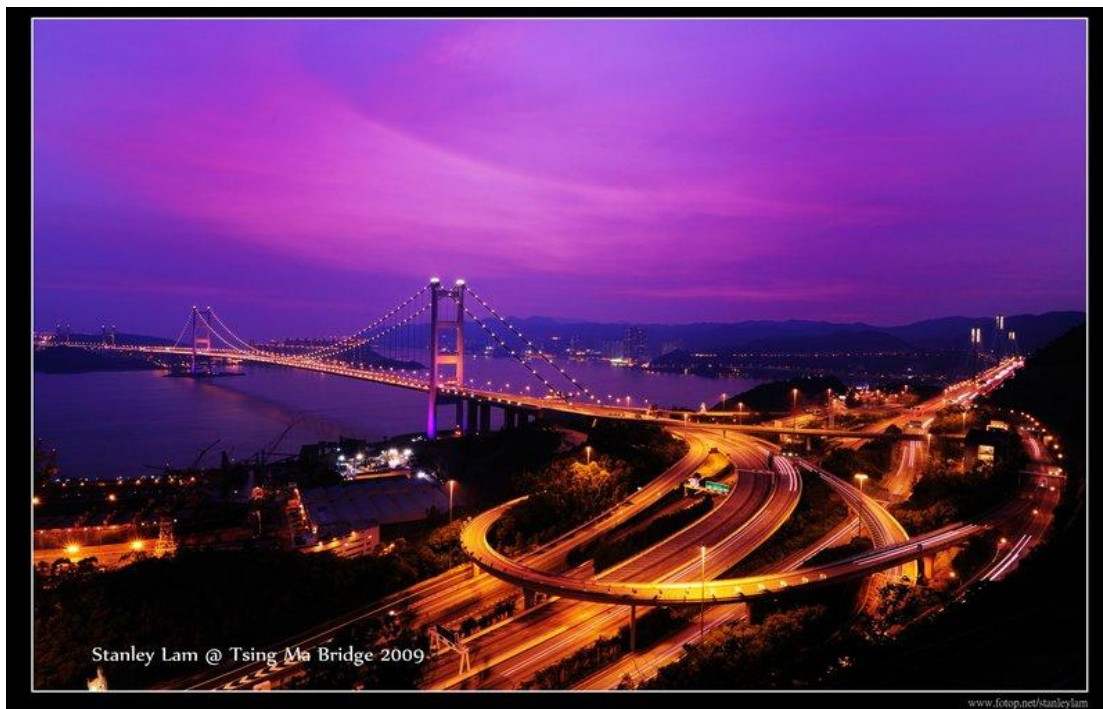
Εικόνα 2- 66 Οι κόμβοι προσέγγισης της γέφυρας (43)
