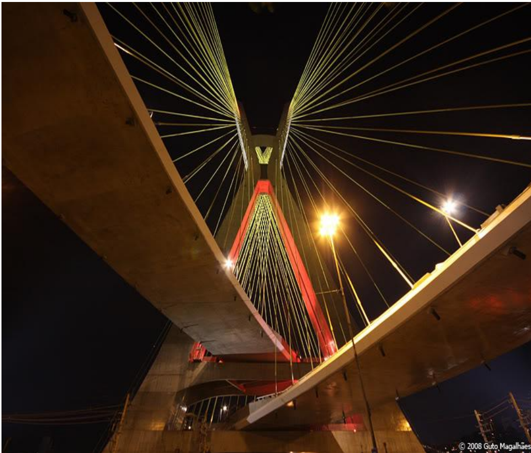
Εικόνα 2- 29 Ο τρόπος διασταύρωσης των καταστρωμάτων (22)
