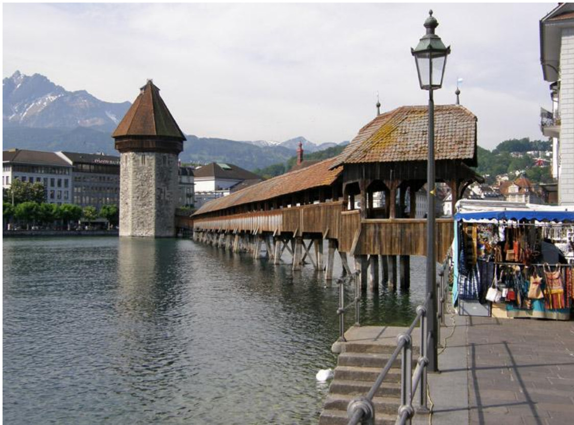
Εικόνα 2- 20 Η άλλη όψη της γέφυρας (16)
