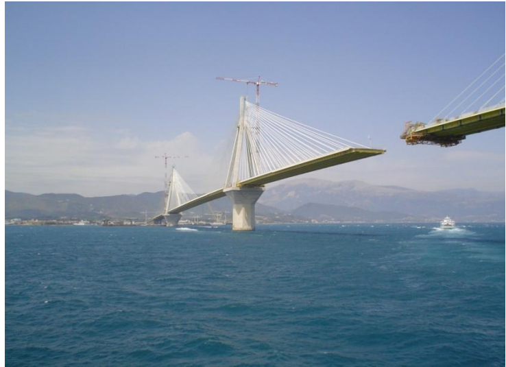
Εικόνα 5- 6 Κατασκευή καταστρώματος
