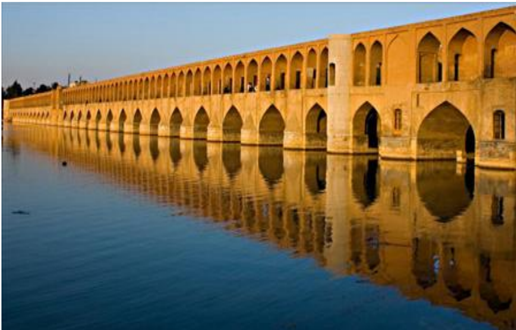
Εικόνα 2- 18 Τα τόξα της γέφυρας (13)
