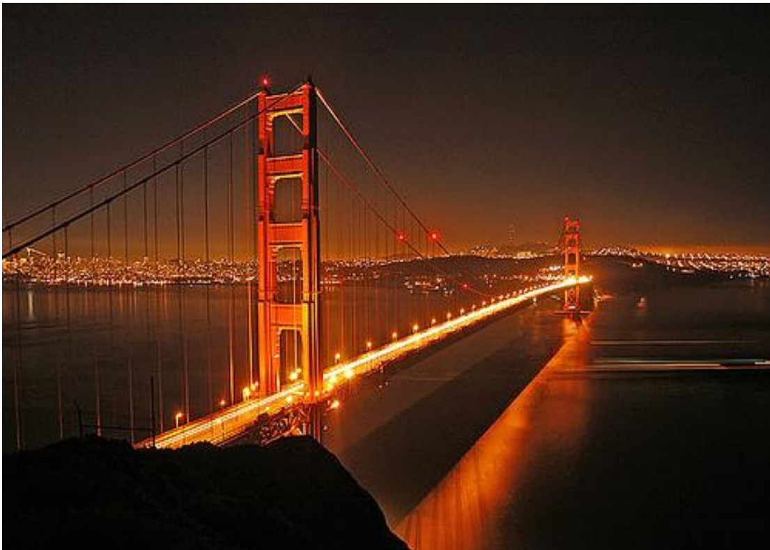
Εικόνα 2- 1 Νυχτερινή άποψη της γέφυρας Golden Gate (3)
