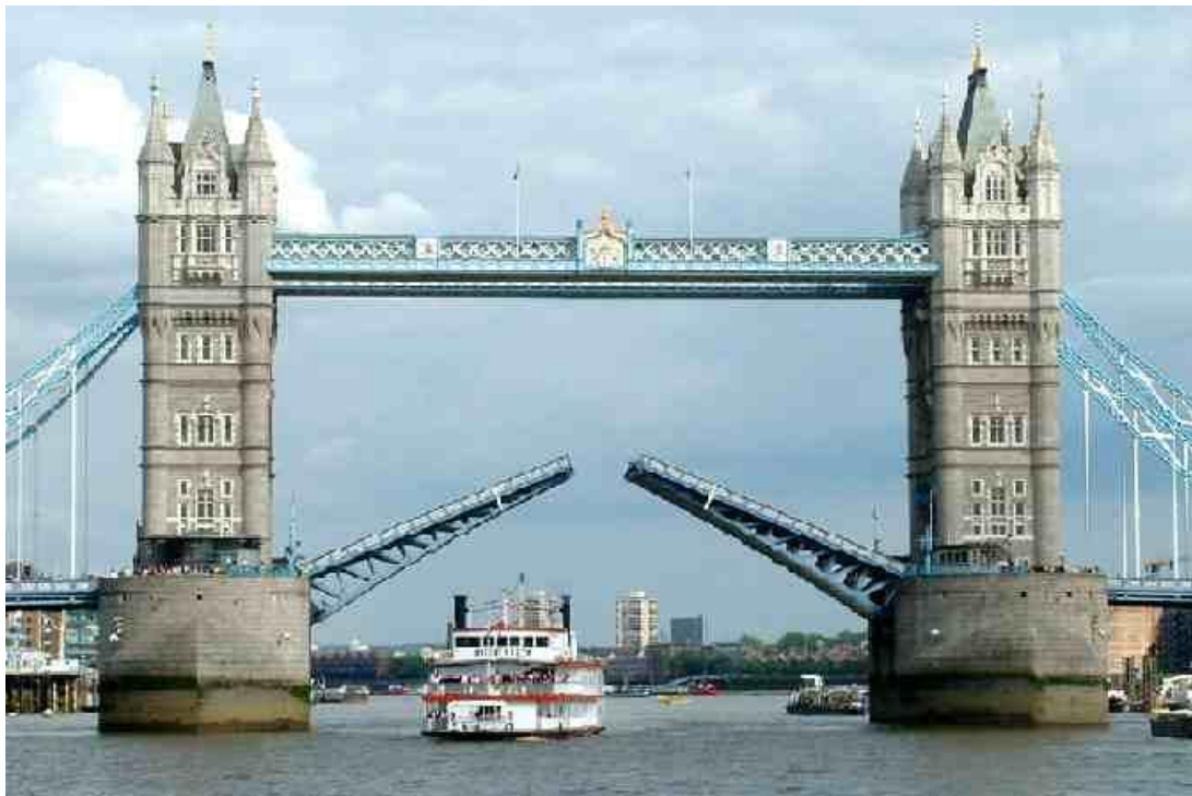
Εικόνα 2- 9 Τα κινητά σκέλη της γέφυρας (9)
