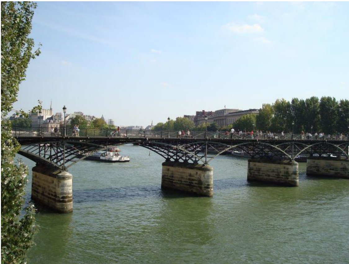
Εικόνα 2- 60 Οι αψίδες της γέφυρας (39)
