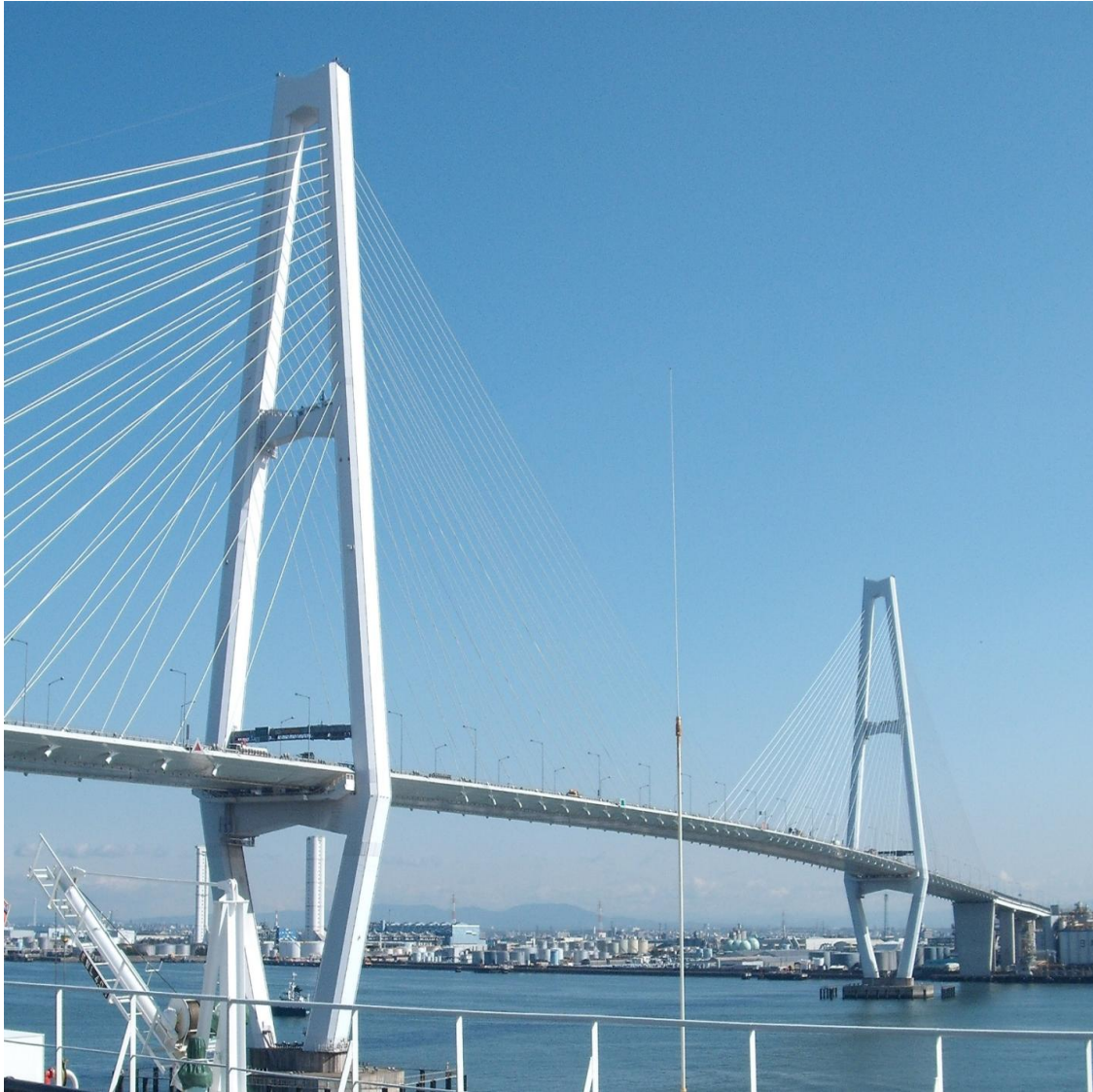
Εικόνα 3- 26 Οι πυλώνες έχουν ύψος 190 μέτρα (78)
