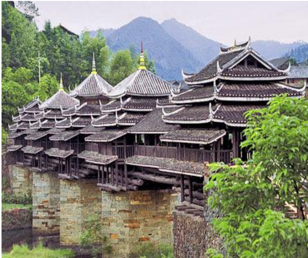
Εικόνα 2- 38 Τα «μπαλκόνια» της γέφυρας (27)
