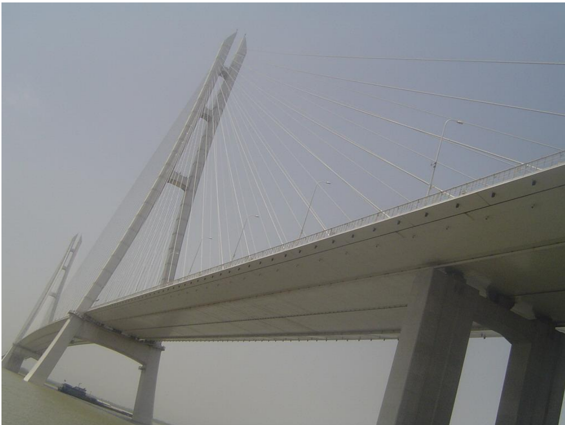
Εικόνα 3- 9 Λήψη που φανερώνει το πραγματικά εντυπωσιακό μέγεθος του πυλώνα (64)
