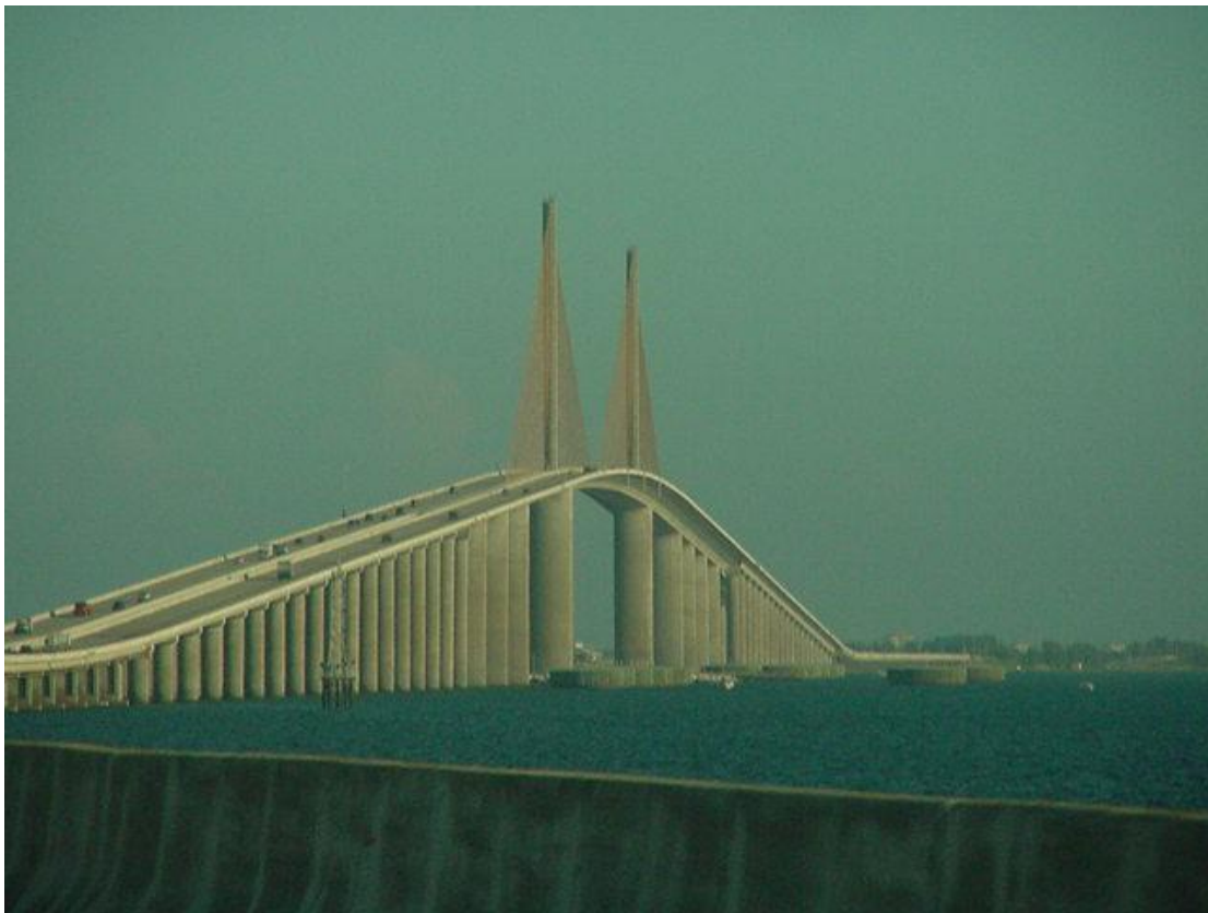
Εικόνα 2- 46 Η ανύψωση του καταστρώματος (31)
