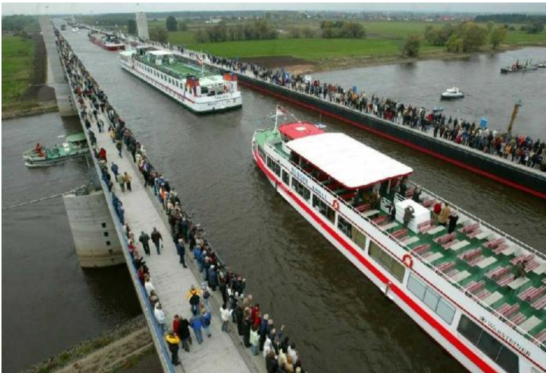
Εικόνα 2- 33 Μετακίνηση πλοίων μέσω της γέφυρας (24)
