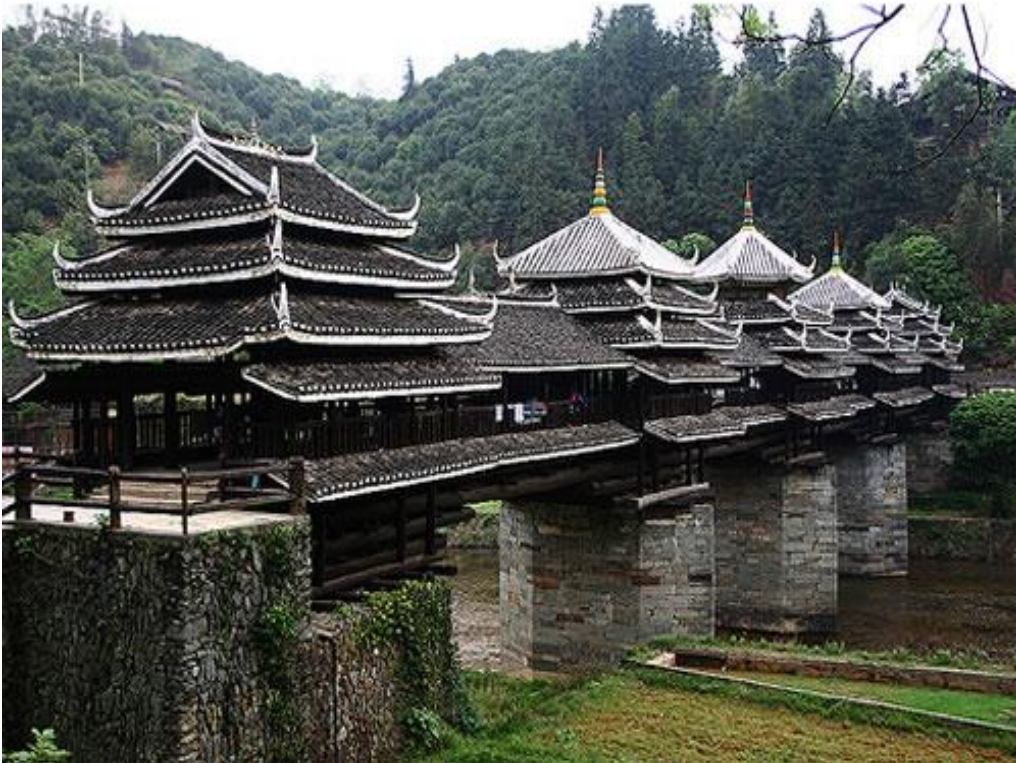
Εικόνα 2- 37 Η γέφυρα Chengyang (27)
