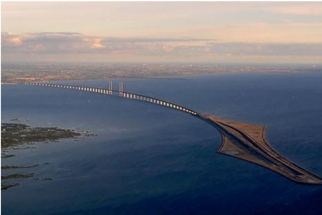
Εικόνα 2- 44 Όλο το μήκος της υπερθαλάσσιας γέφυρας (29)
