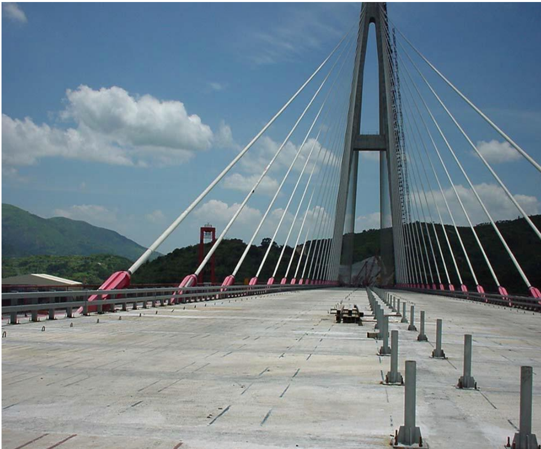
Εικόνα 3- 15 Η γέφυρα κατά την κατασκευή (71)
