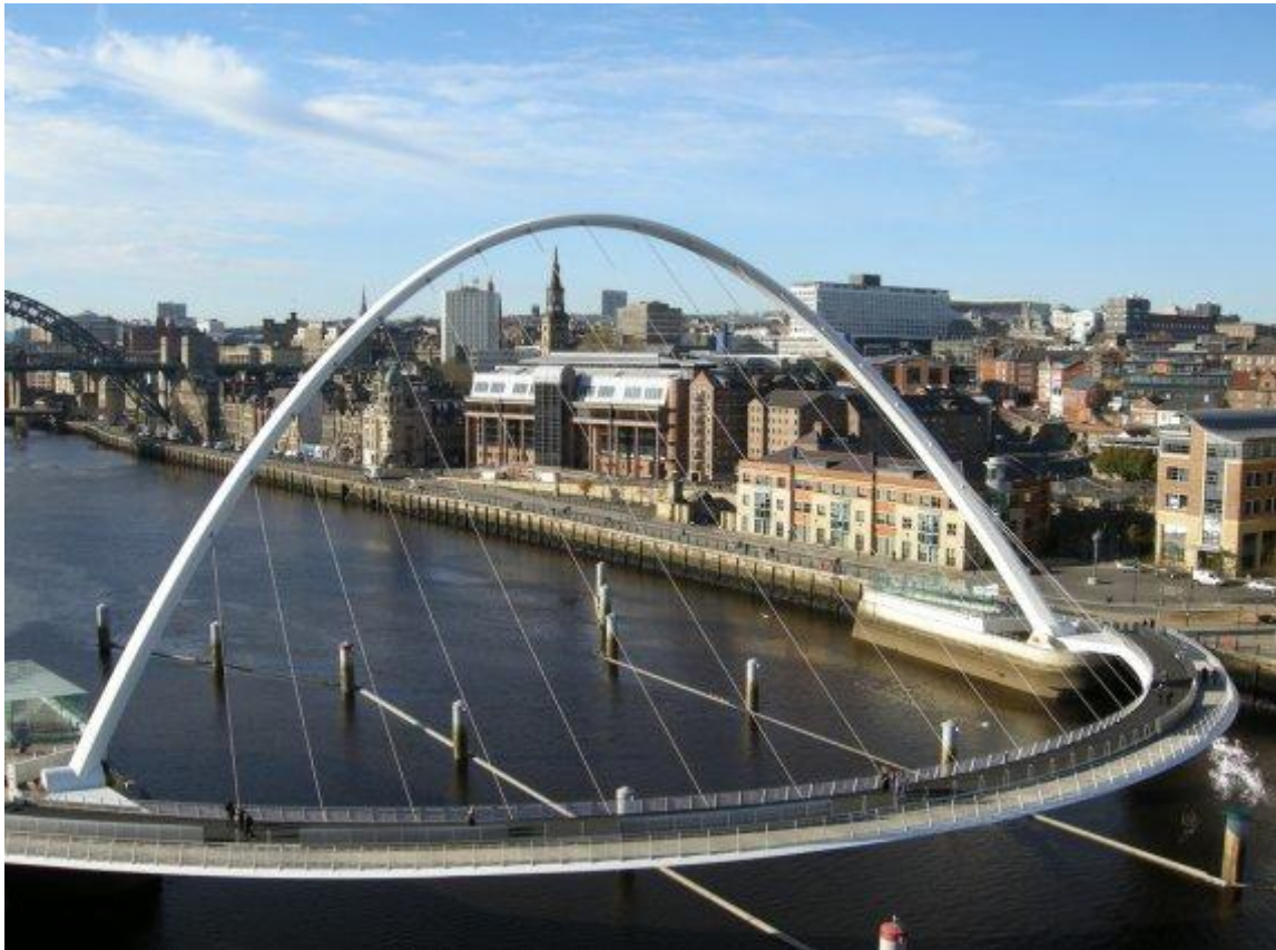
Εικόνα 2- 34 Η γέφυρα Gateshad Millenium (26)
