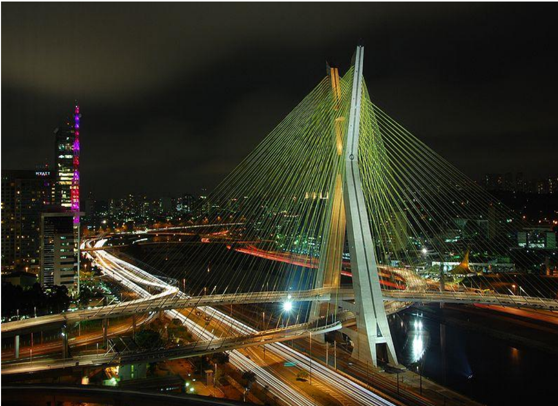
Εικόνα 2- 28 Φωτισμένα τα καλώδια της γέφυρας (22)
