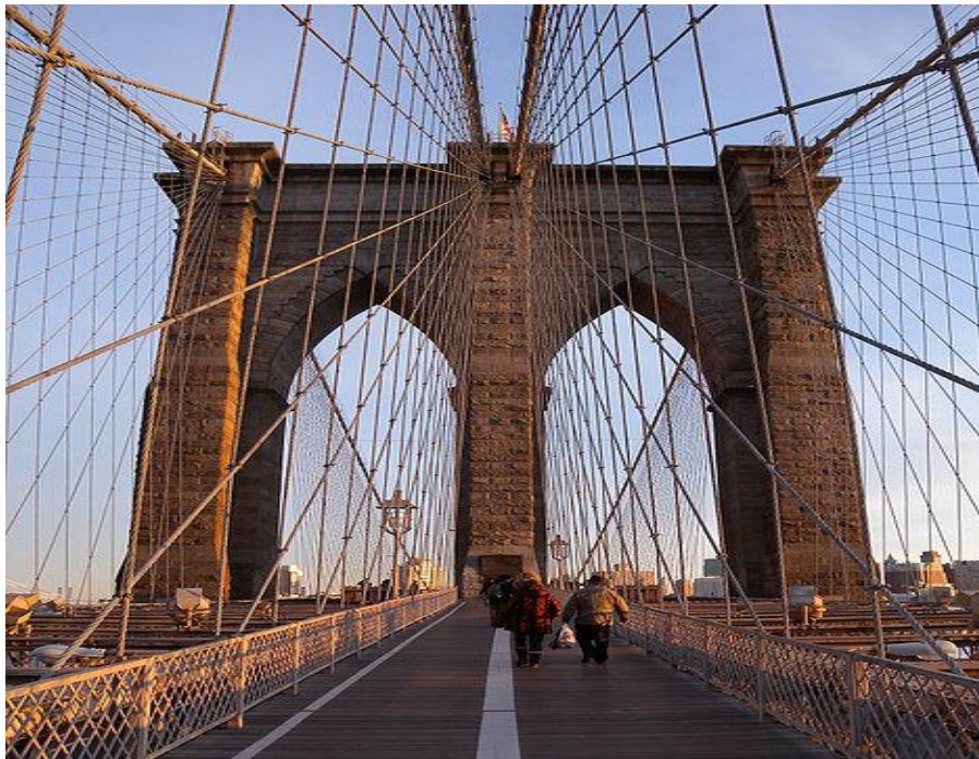
Εικόνα 2- 6 Άποψη του πυλώνα (7)
