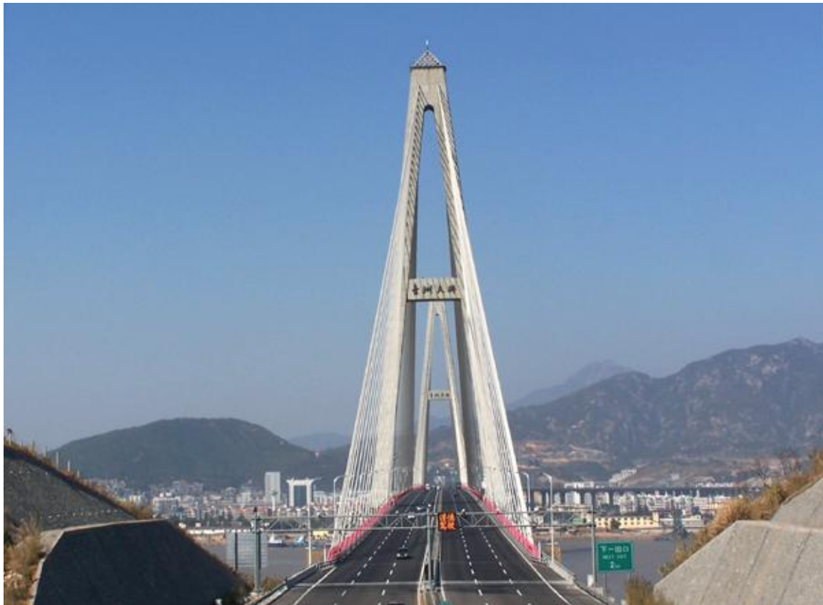
Εικόνα 3- 17 Το κατάστρωμα της γέφυρας (72)
