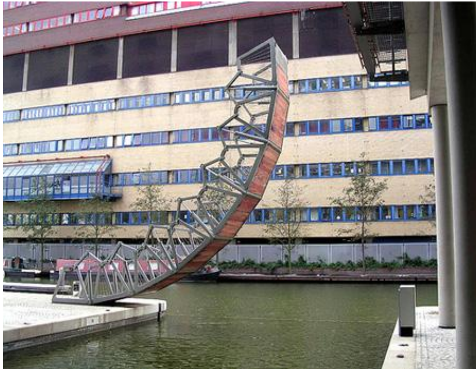
Εικόνα 2- 63 Η γέφυρα κατά το άνοιγμά της (41)
