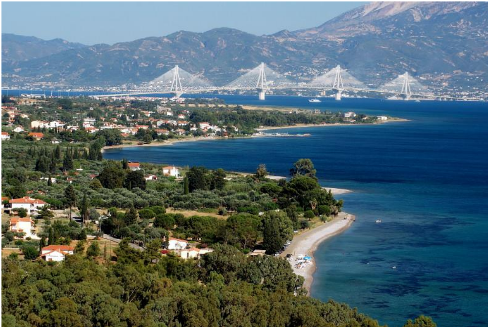
Εικόνα 7- 7 Η γέφυρα από την πλευρά του Ρίου (87)
