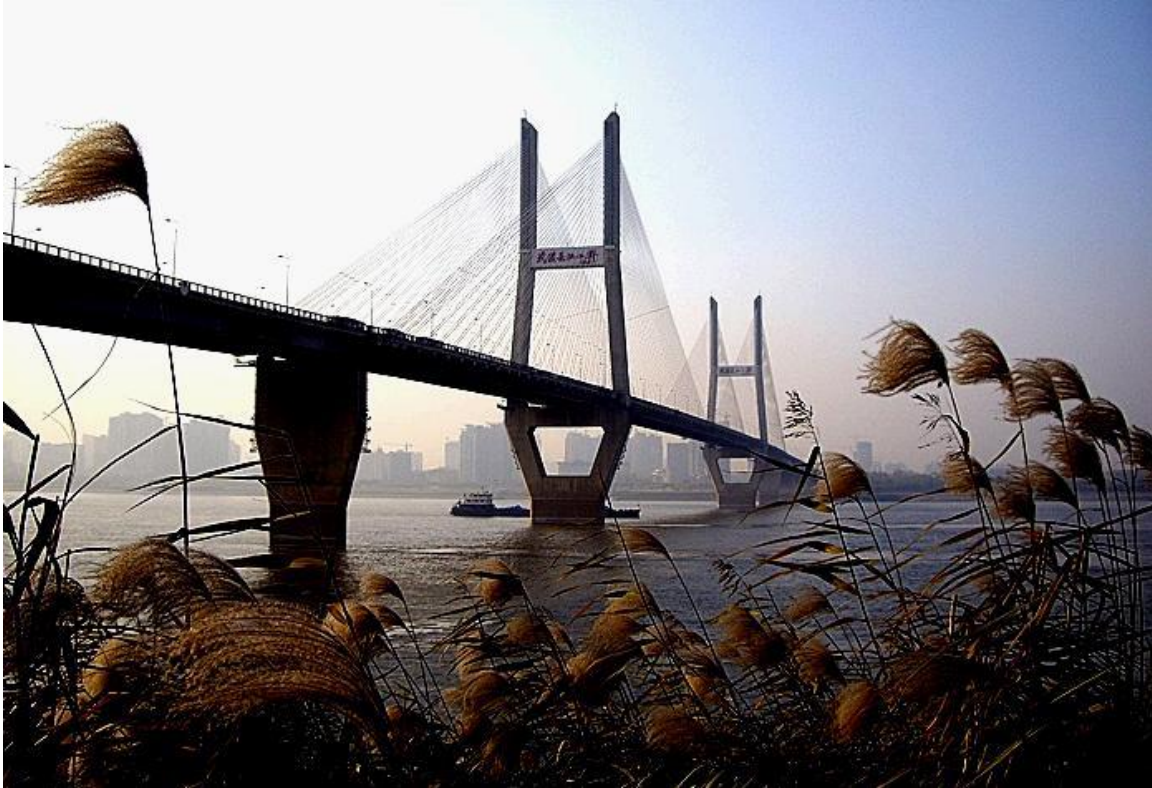
Εικόνα 3- 12 Η ιδιαίτερη αρχιτεκτονική των πυλώνων (66)
