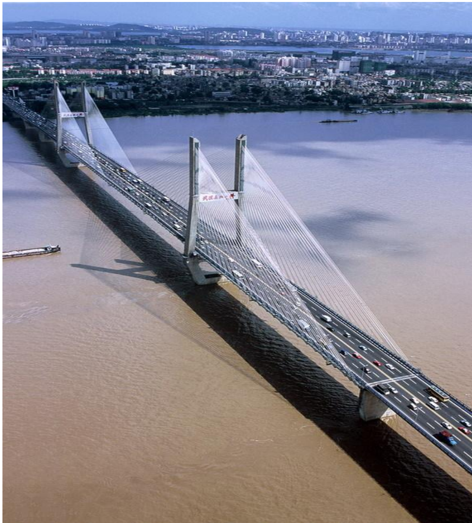
Εικόνα 3- 11 Η δεύτερη γέφυρα του ποταμού Yangtze (66)
