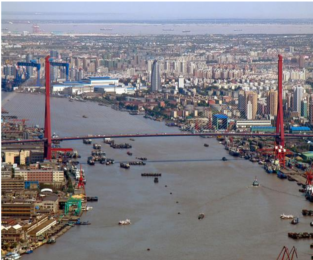
Εικόνα 3- 18 Η γέφυρα Yangpu
