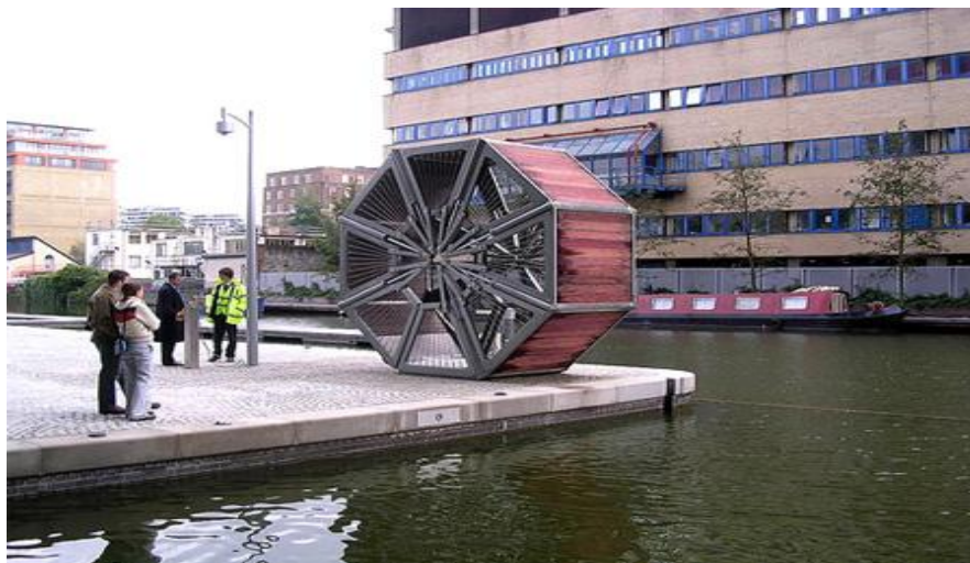
Εικόνα 2- 62 Η γέφυρα κλειστή (41)
