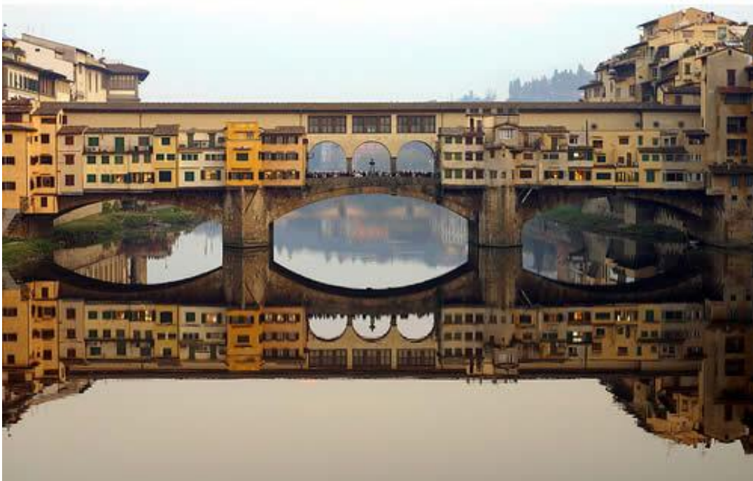
Εικόνα 2- 13 Τα μαγαζάκια πάνω στην γέφυρα (12)
