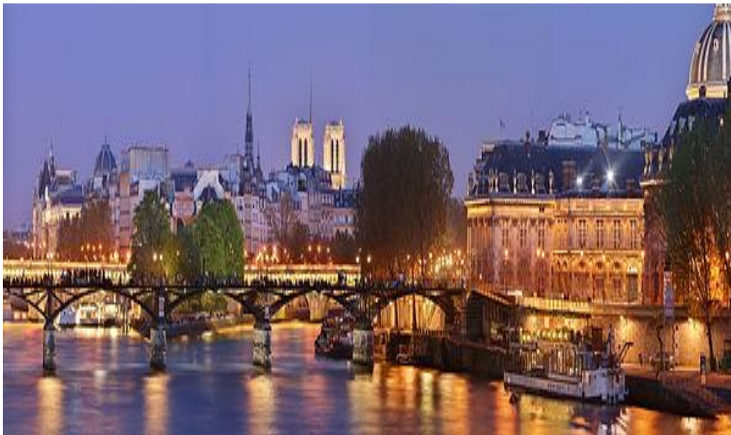
Εικόνα 2- 59 Όψη της γέφυρας (39)
