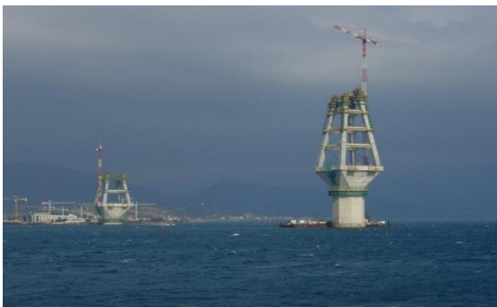
Εικόνα 5- 15 Κατασκευή πυλώνων
