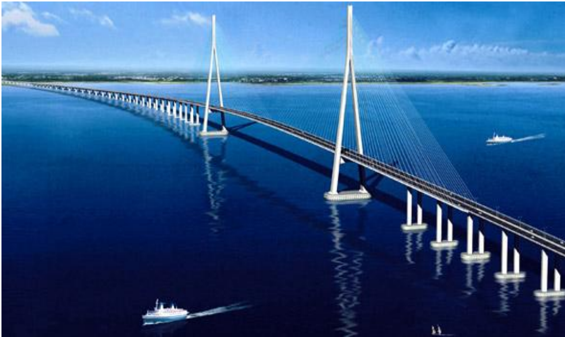
Εικόνα 3- 1 Η γέφυρα Sutong (57)
