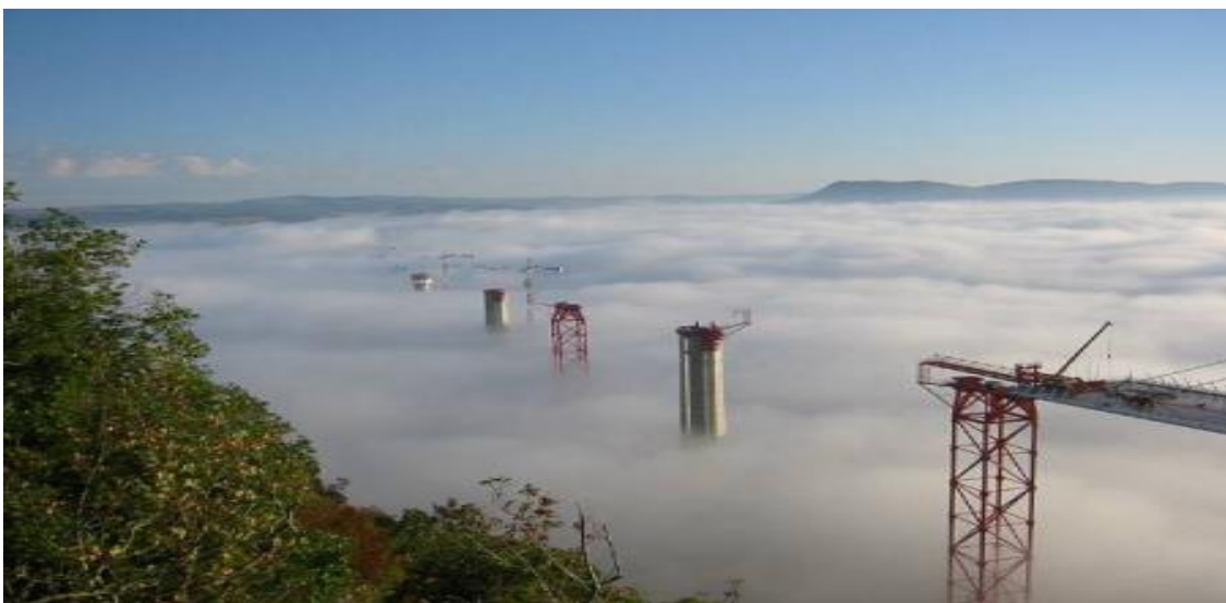
Εικόνα 2- 76 Εύλογες δυσκολίες κατά την κατασκευή (50)
