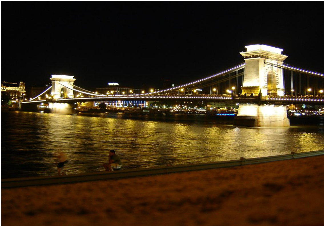
Εικόνα 2- 22 Νυχτερινή άποψη της γέφυρας (18)
