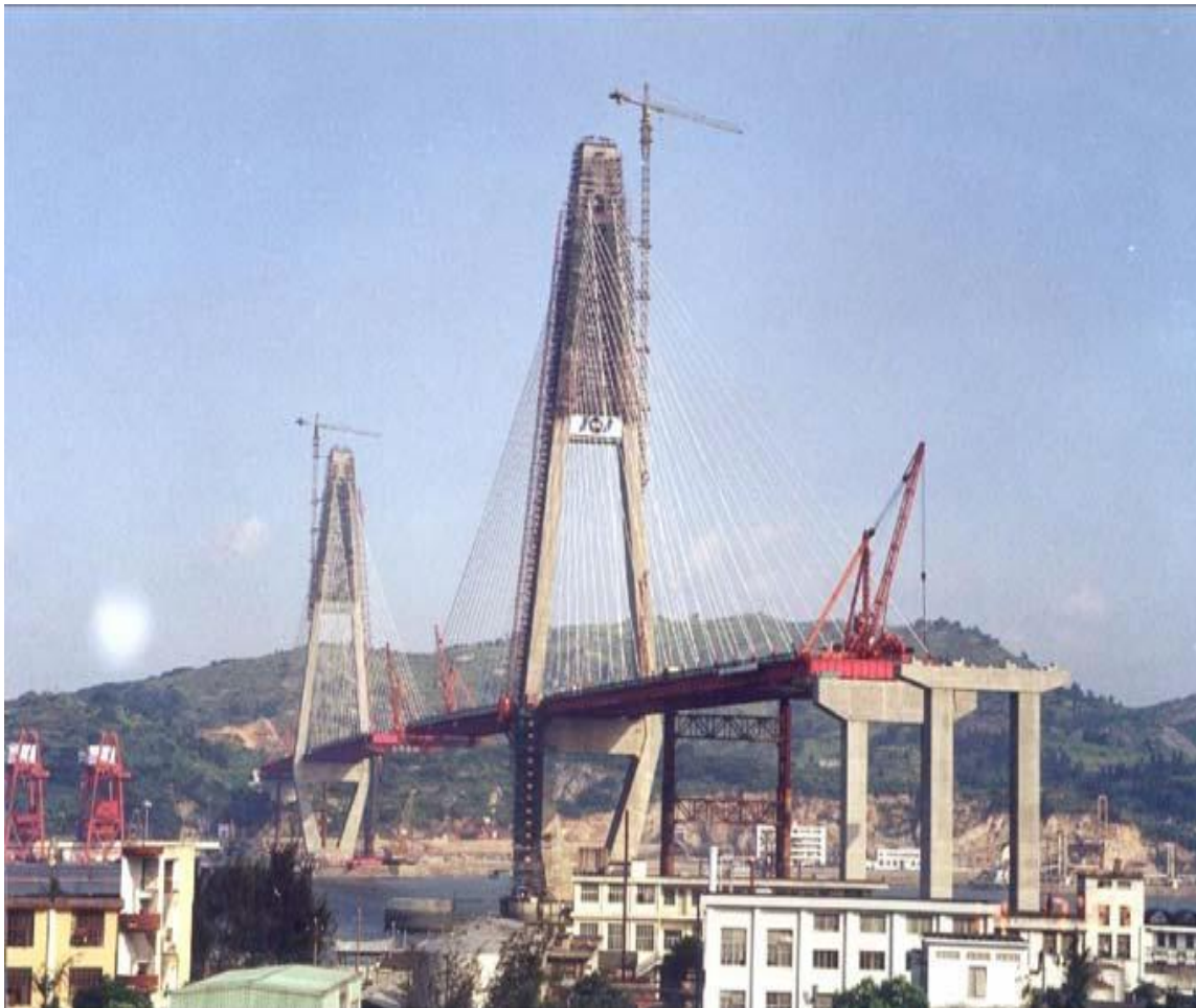
Εικόνα 3- 16 Η κατασκευή του καταστρώματος (72)
