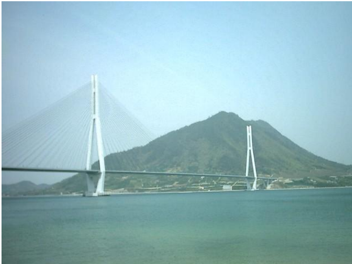
Εικόνα 3- 5 Το άνοιγμα της γέφυρας Tataara φθάνει τα 890 μέτρα (60)
