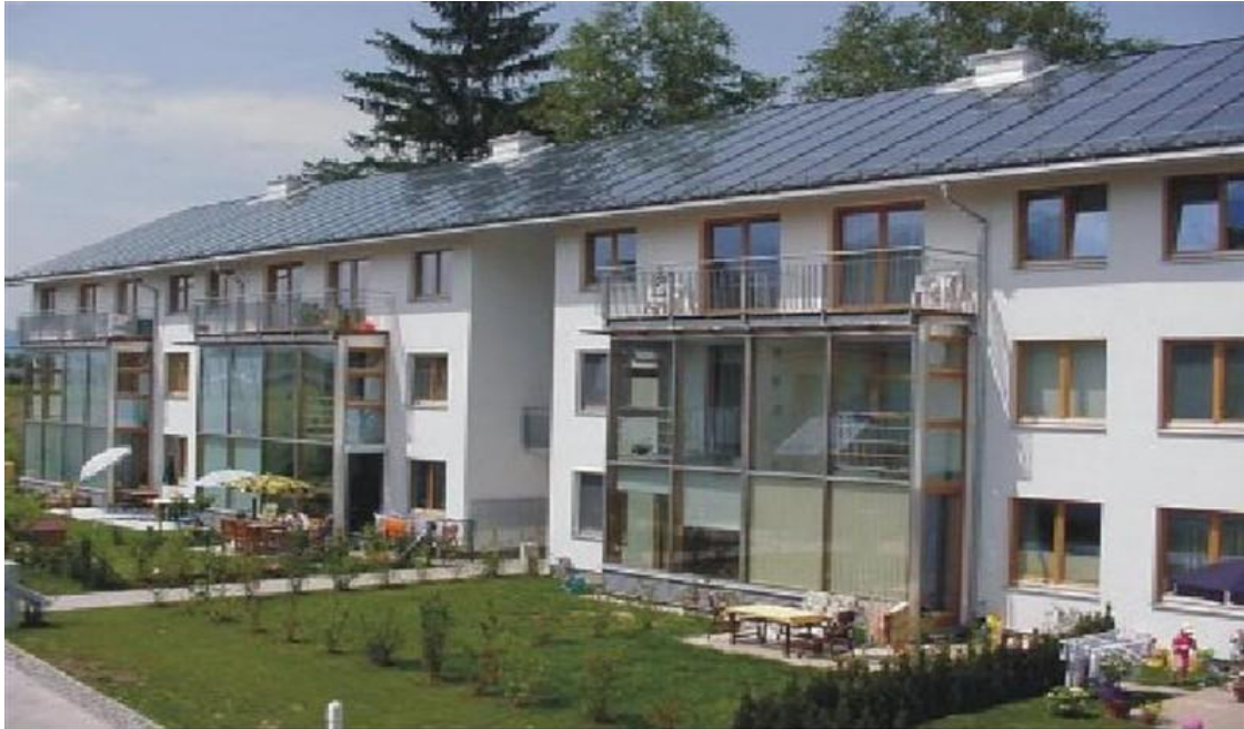
Εικόνα 1.22: Σύστημα Combi στο Gneis-Moos της Αυστρίας στο οποίο οι ηλιακοί συλλέκτες αποτελούν τη στέγη του κτιρίου και το οποίο καλύπτει το 40% των συνολικών αναγκών για θέρμανση και ζεστό νερό χρήσης (Πηγή: http://www.monachos.gr/forum/topic.asp?TOPIC_ID=1575 )
