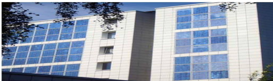
Εικόνα 1.8: Φωτοβολταϊκά σε πρόσοψη κτιρίου
