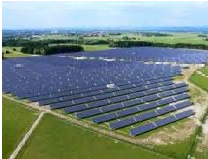
Σχήμα 5.15: Άποψη φωτοβολταϊκού πάρκου
