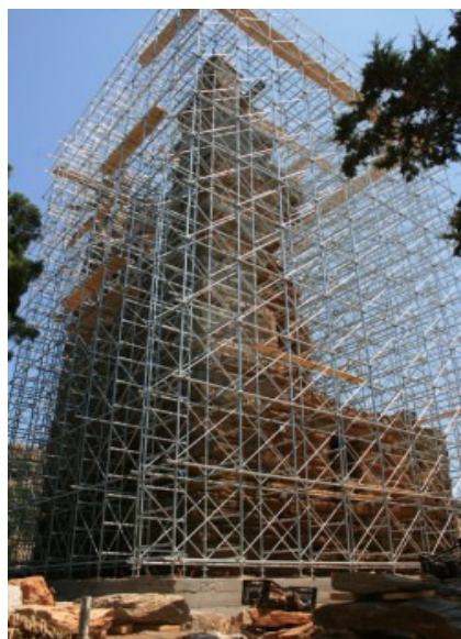
εικόνα 4.1.1β: Φωτογραφία πύργου
