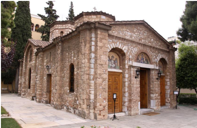
εικόνα 2.2.4.4: Φωτογραφία Ιερού Ναού Ασωμάτων της Μονής Πετράκη
