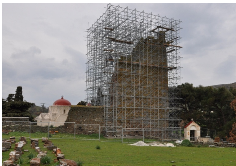
εικόνα 4.2.1: Βορεινή όψη και περίφραξη
