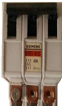
Εικόνα 2.5 Τριφασικός διακόπτης SIEMENS STE1 413
