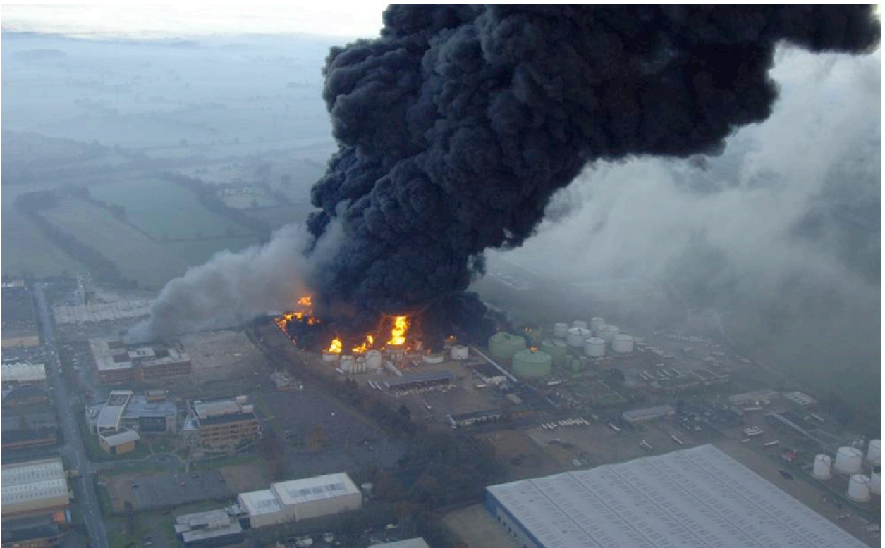
Εικόνα 3: Μέρος της εγκατάστασης του Buncefield Oil Storage Terminal κατά την διάρκεια του ατυχήματος © Chiltern Air Support.
