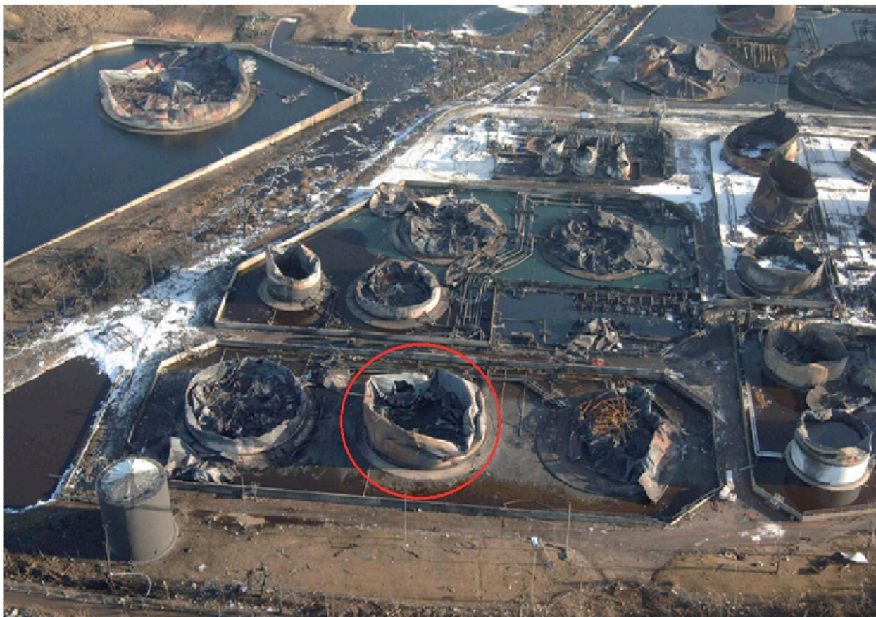
Εικόνα 4: Πανοραμική άποψη της εγκατάστασης Buncefield Oil Storage Terminal μετά το ατύχημα. Σε κόκκινο κύκλο διακρίνεται η δεξαμενή No 912 από όπου υπήρξε η υπερχειλίση καυσίμου. © Chiltern Air Support.
