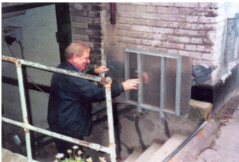
Εικόνα 2.11 - Ανελκυστήρας για τη μεταφορά κάδων από επίπεδο υπό της οδού στη θέση εκκένωσης.
