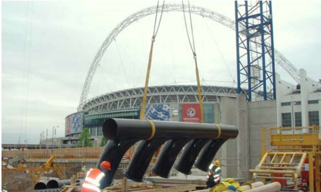
Εικόνα 3.29 - Εργασίες στο Brent Civic Centre, UK
