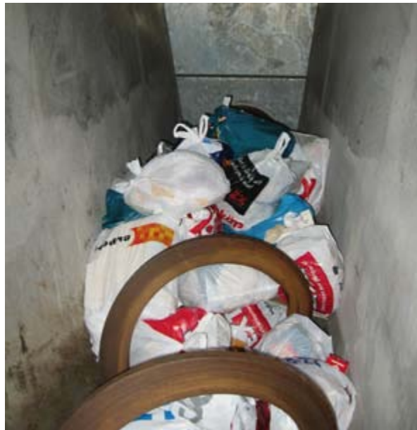
Εικόνα 2.15- Κατασκευή διαμόρφωσης των σακουλών
