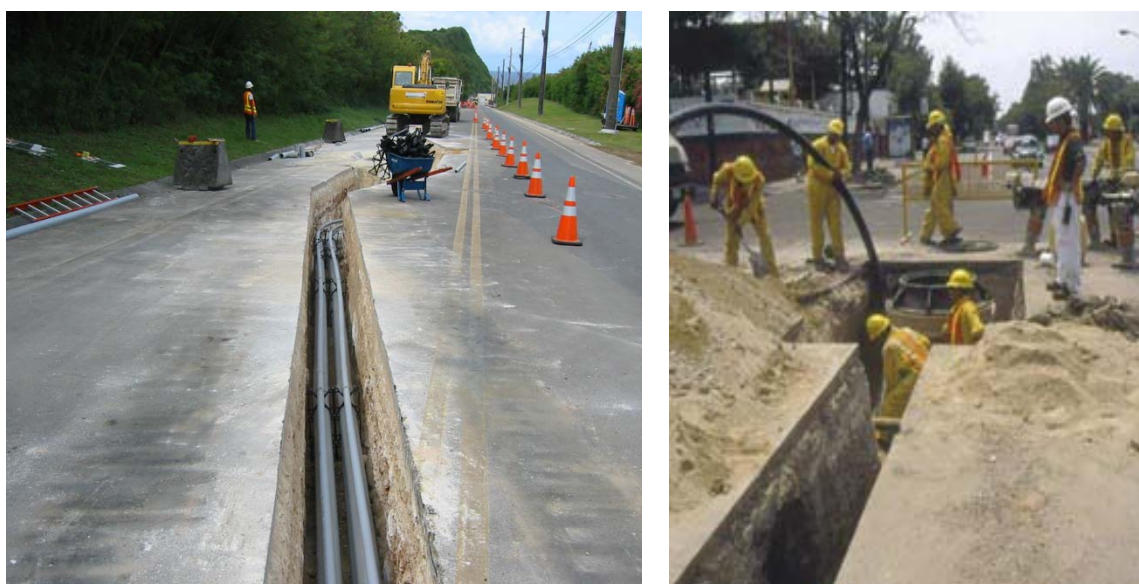
Εικόνα 4.14- Απεικόνιση Εργασιών κατά τη διάνοιξη με ανοιχτή εκσκαφή
