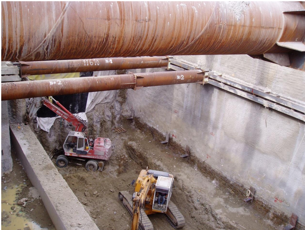
Φωτο Β3. Από το όρυγμα του δυτικού φρέατος στον σταθμό του Περιστερίου.
