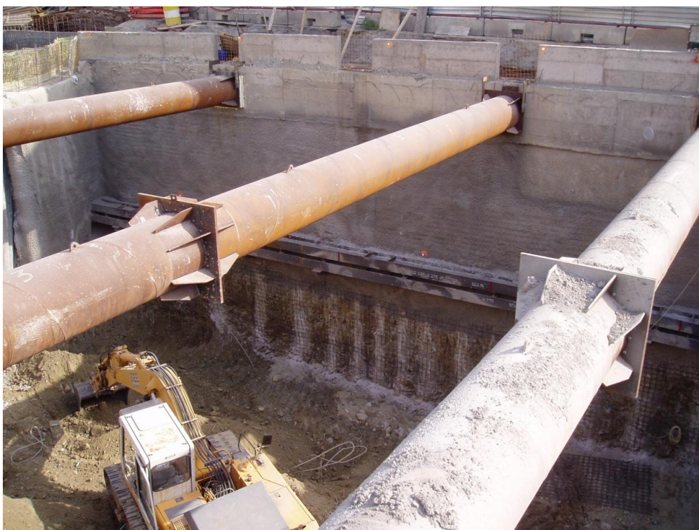
Φωτο Β1. Αντηρίδες με πετάσματα φρεατοπασσάλων, στο όρυγμα του Δυτικού φρέατος στον σταθμό του Περιστερίου.
