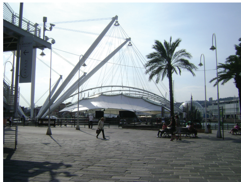
εικ.71: Η κατασκευή Bigo με το στέγαστρο που φιλοξενεί αθλητικές και πολιτιστικές χρήσεις.
