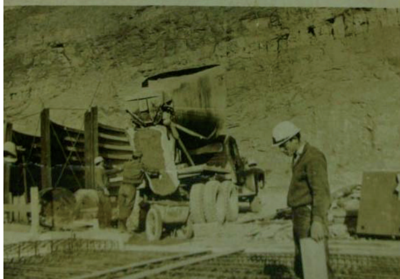
Εικ. 16 Στιγμές από την κατασκευή του φράγματος στα Κρεμαστά πηγή: Αρχείο Ευγένιου Τσαβαλιά
