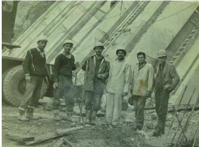
Εικ. 17 Στιγμές από την κατασκευή του φράγματος στα Κρεμαστά πηγή: Αρχείο Ευγένιου Τσαβαλιά
