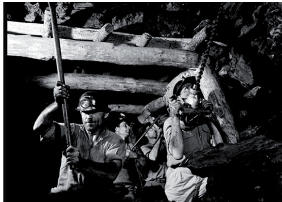
Εικ. 47 Λιγνιτωρυχείο Αλιβερίου, 1957 πηγή: DEL_GR's photostream
