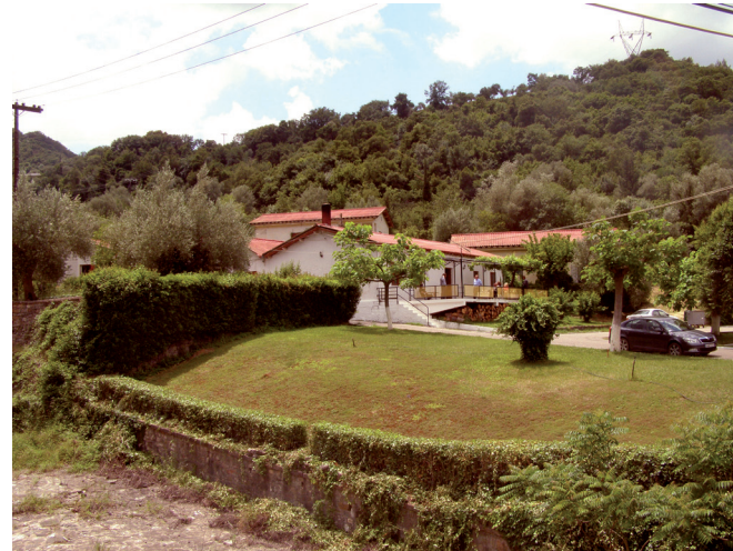
Εικ. 30. Σε πρώτο πλάνο φαίνεται το κτήριο του εστιατορίου. Παράλληλόγραμμο κτήριο, με δίριχτη κεραμοσκεπή και τζάκι. Με τα ίδια υλικά είναι κατασκευασμένα και τα υπόλοιπα κτήρια αυτής της ενότητας, που φαίνονται στο βάθος της φωτογραφίας.
