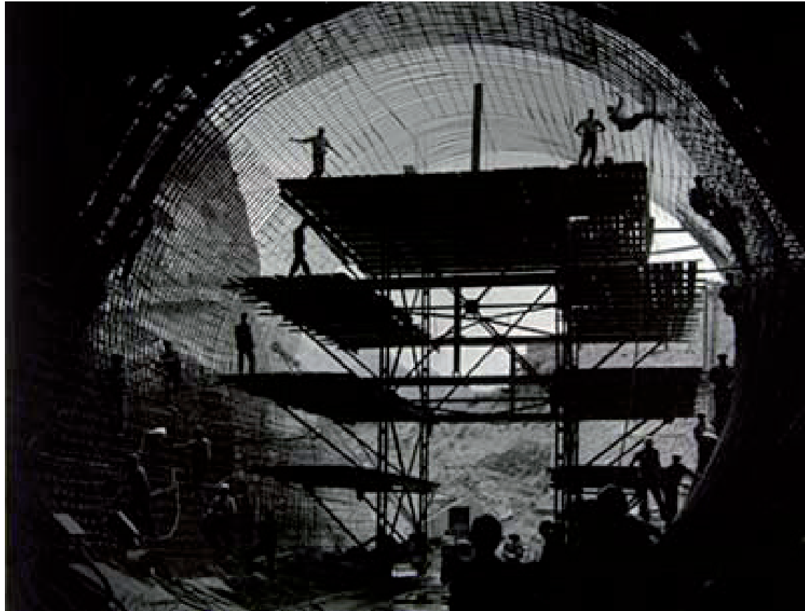
Εικ. 14 Κατασκευή σήραγγας εκτροπής στα Κρεμαστά, 1962 πηγή: Αρχείο Κώστα Μπαλάφα*
