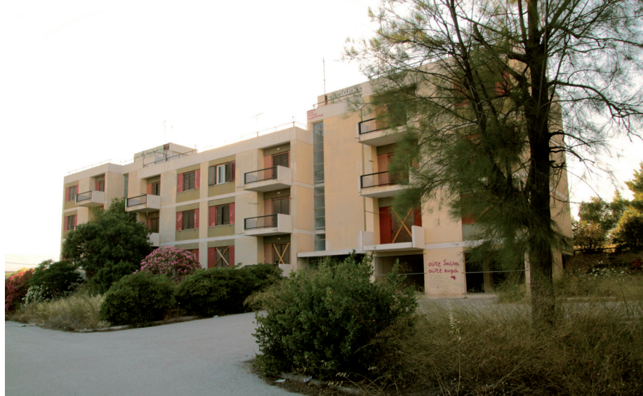
Εικ. 61 Όψη πολυκατοικίας της ΔΕΗ από τον περιμετρικό δρόμο. Σήμερα οι πολυκατοικίες παραμένουν στο σύνολό τους εγκαταλελειμμένες, εξαιτίας στατικών προβλημάτων που έχουν εμφανίσει.
