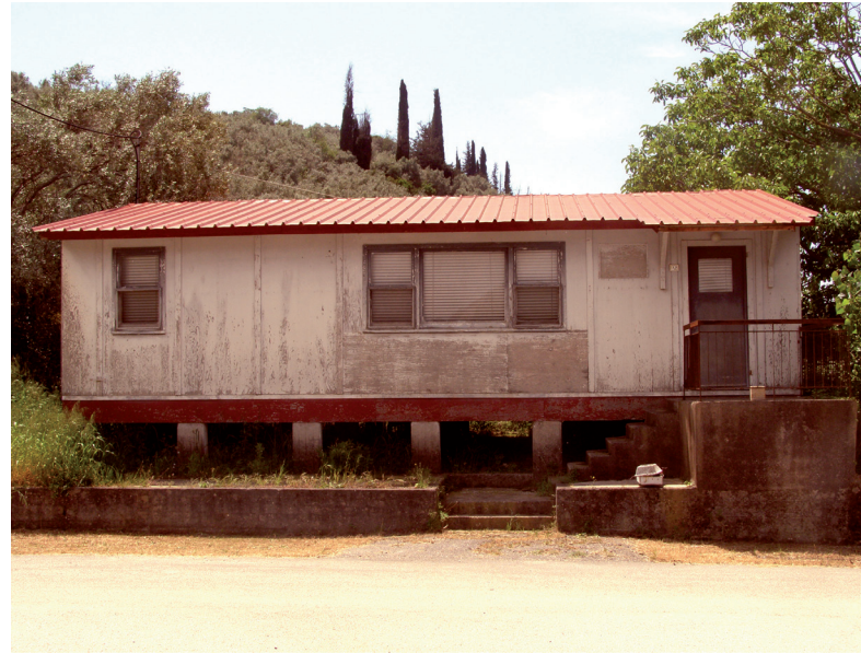
Εικ. 40 Ξύλινη μονοκατοικία, 2012. πηγή: Προσωπικό Αρχείο
