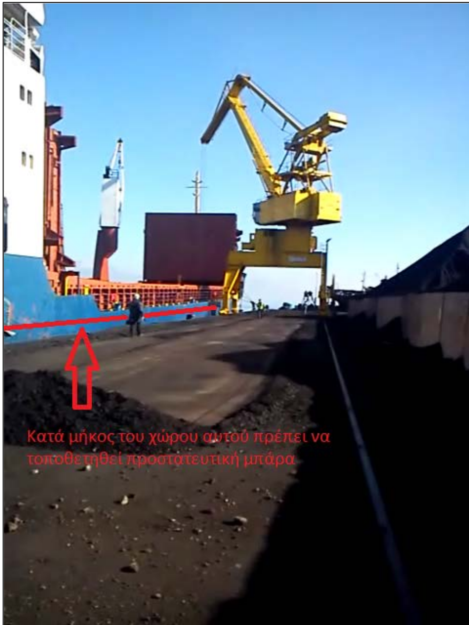
Εικόνα 4-11: Χώρος προβλήτας (Τοποθέτηση προστατευτικής μπάρας)
