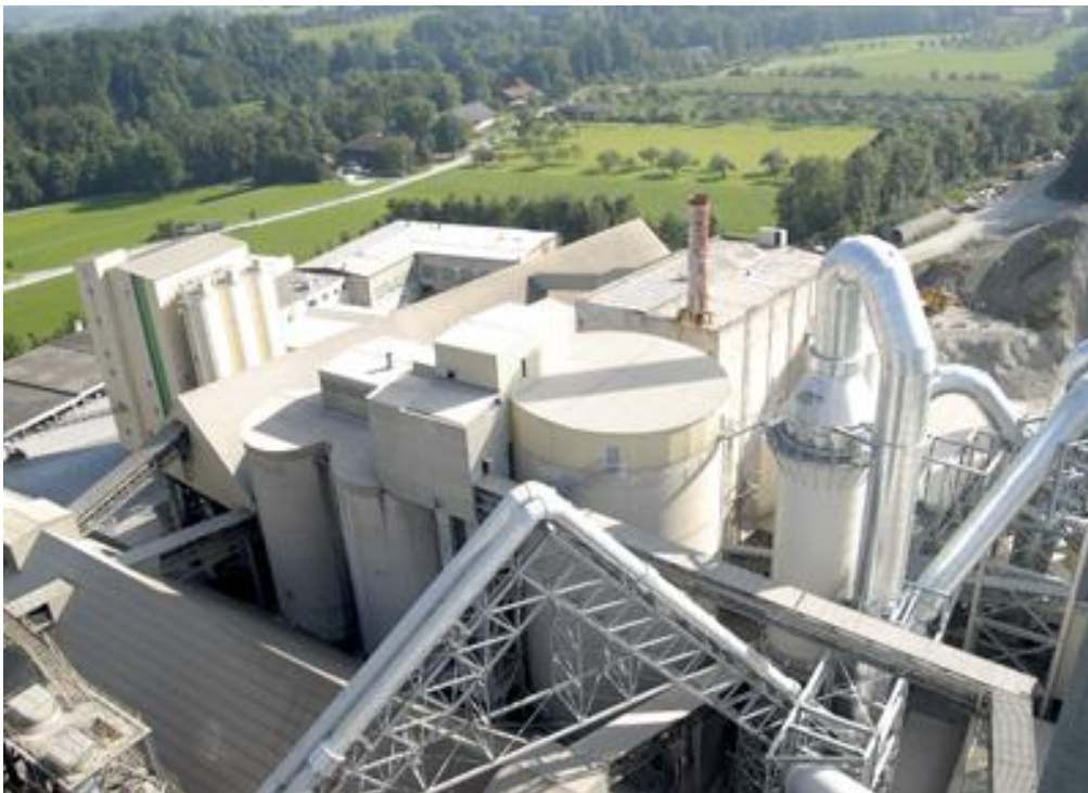
Σχήμα 3.4 Υπό κατασκευή σταθμός στο Rohrdorf [19]
