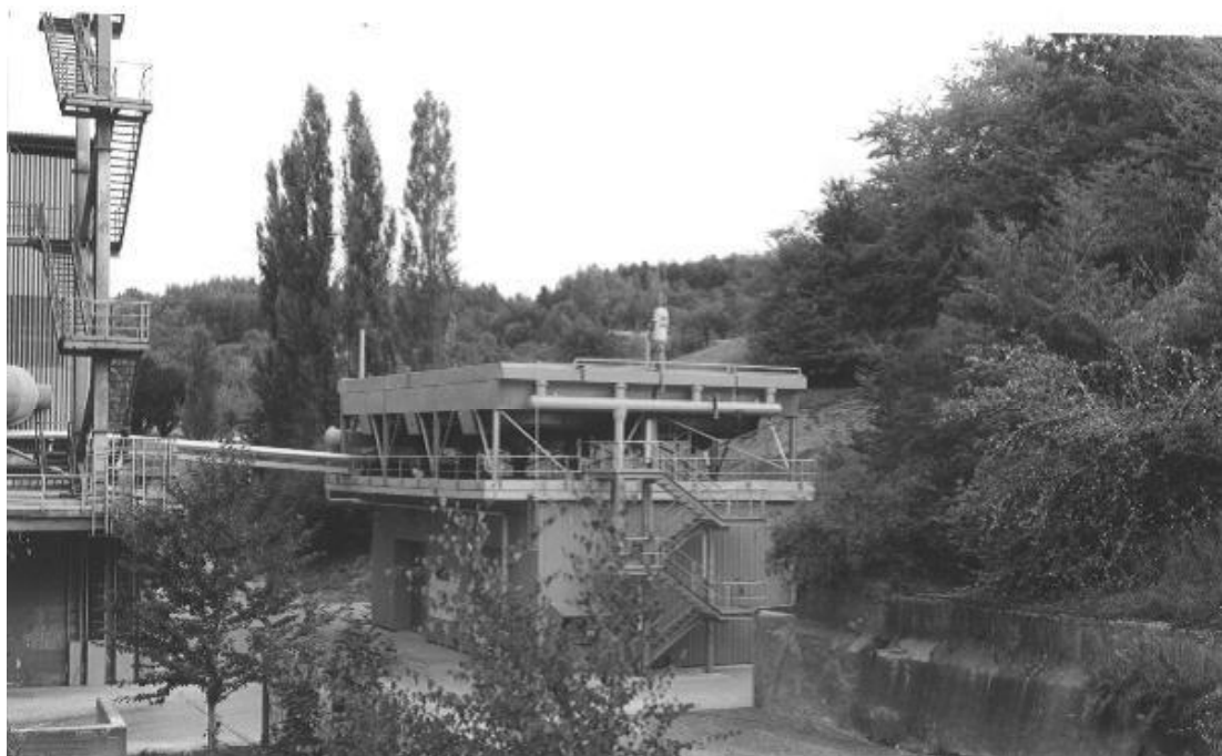
Σχήμα 3.3 Σταθμός στο Lengfurt [17]
