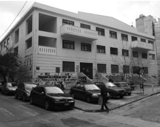
5. δημοτικό_νηπιαγωγείο επί της Ευγ. Καραβία
