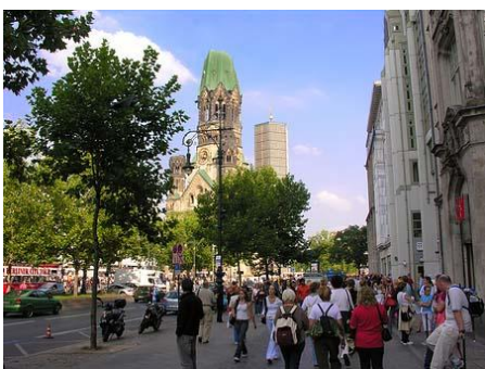
Η λεωφόρος Kurfürstendamm με σημείο αναφοράς την Gedächtniskirche στο βάθος με την εκκλησία του Egon Eirmann (πηγή: www.berlin.citysam.de )
