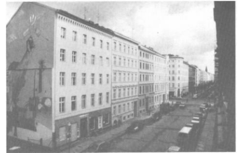
Kreuzberg, η τήρηση της οικοδομικής γραμμής, η συνέχεια της απόληξης της στέγης, η ομοιογένεια των όψεων, διαμόρφωσαν ένα ενδιαφέροντα και πειθαρχημένο αστικό χώρο (πηγή: Κούκης Ι., 2000)
