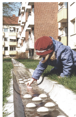
Εικ.12, 13, 14: Ανοικτά κανάλια απορροής του νερού της βροχής με τους σχηματισμούς σε σχήμα σταγόνας που ρυθμίζουν τη ροή.
