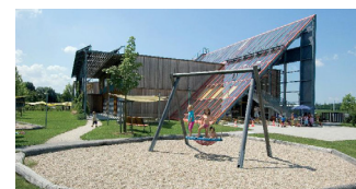
Εικ.23: Ηλιακές εγκαταστάσεις στο νηπιαγωγείο
