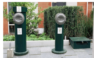
Εικ.36: Δοχεία απόρριψης απορριμμάτων που συνδέονται με υπόγειο δίκτυο αγωγών
