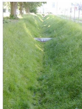
Εικ.10: Σύμφωνα με τον Schroepfer T., οι τάφροι βάθους ενός μέτρου για την απορρόφηση του νερού της βροχής δεν αποτελούν την καλύτερη δυνατή λύση από άποψη αισθητικής και λόγω της αχρείαστης διαπλάτυνσης του δρόμου και της παρεμπόδισης της επικοινωνίας των δύο πλευρών εκατέρωθεν του.
