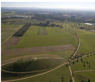
Εικ.30: Διαμόρφωση τοπίου με τα χώματα εκσκαφής
