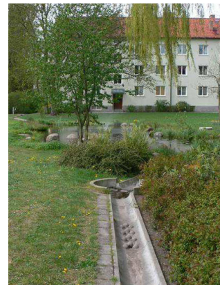
Εικ.12, 13, 14: Ανοικτά κανάλια απορροής του νερού της βροχής με τους σχηματισμούς σε σχήμα σταγόνας που ρυθμίζουν τη ροή.
