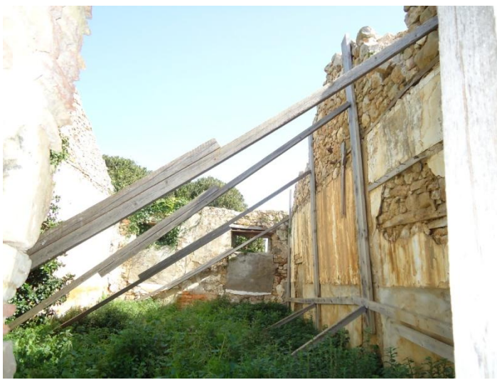
84. Εργασίες στήριξης του ενδιάμεσου τοίχου του κτηρίου.
