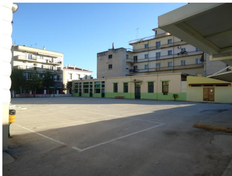
68. Άποψη του προαυλίου. Το μικρό κομμάτι του άσπρου όγκου που διακρίνεται στην φωτογραφία μπροστά και αριστερά είναι το κτήριο του σχολείου.
