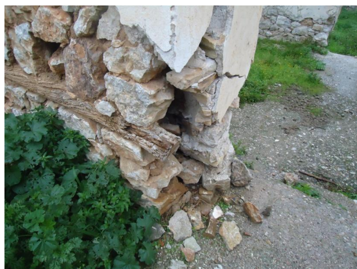
57.Φωτογραφίες του εσωτερικού του κτηρίου. Διακρίνεται η λιθοδομή του κτηρίου, οι ξυλοδεσιές, οι υποδοχές στην τοιχοποιία για τα δοκάρια του πατώματος, τα μεταλλικά στοιχεία των κουφωμάτων.
