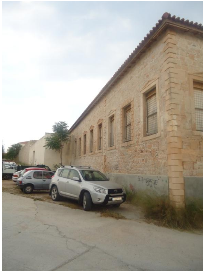
32. Φωτογραφίες των όψεων του συγκροτήματος.
