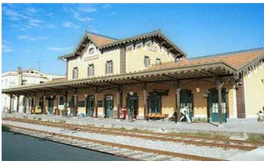
Εικόνα 5.3: Σιδηροδρομικός σταθμός Βελεστίνου
