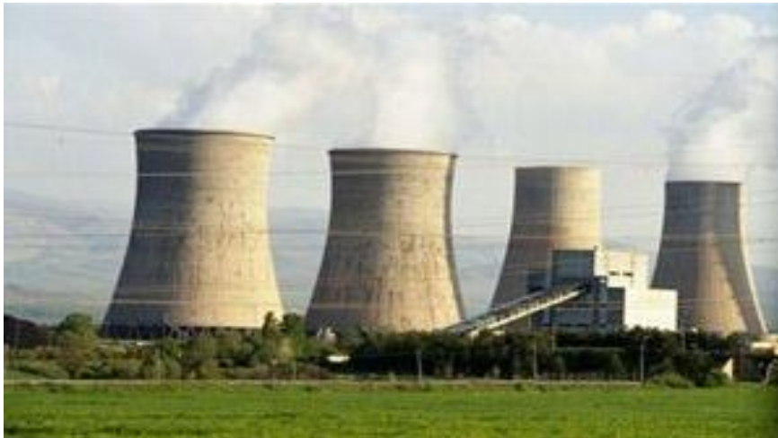
Εικόνα 4.2: Μονάδα παραγωγής θερμότητας
