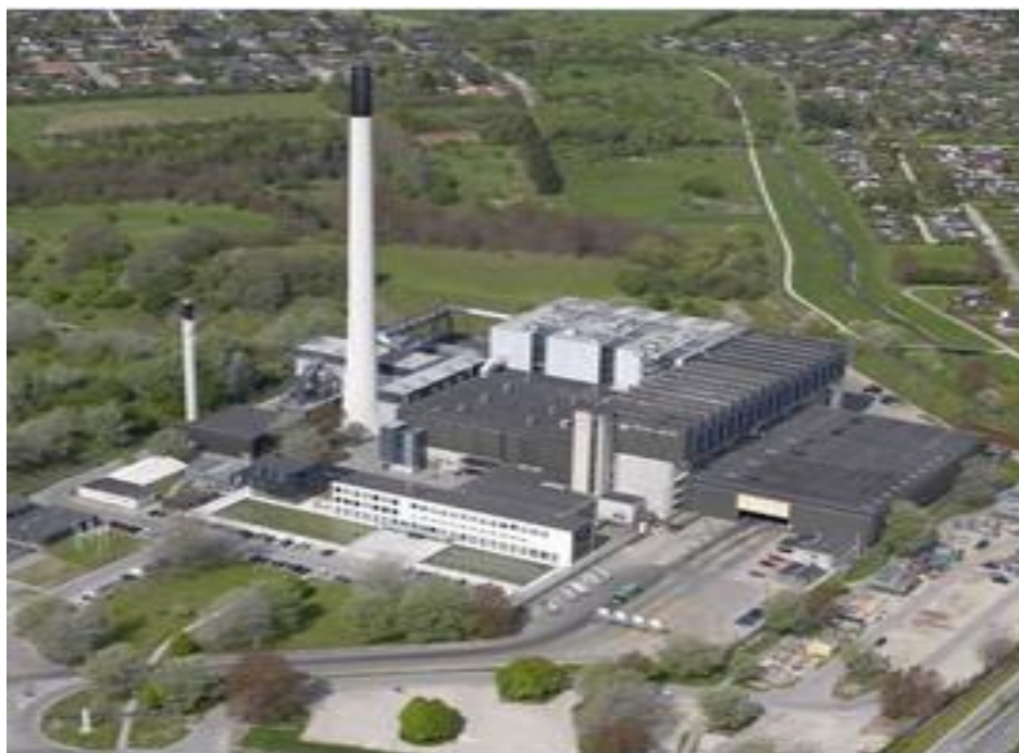
Εικόνα 4.5: Σταθμός συμπαραγωγής στην Κοπεγχάγη, Δανία (600MW)
