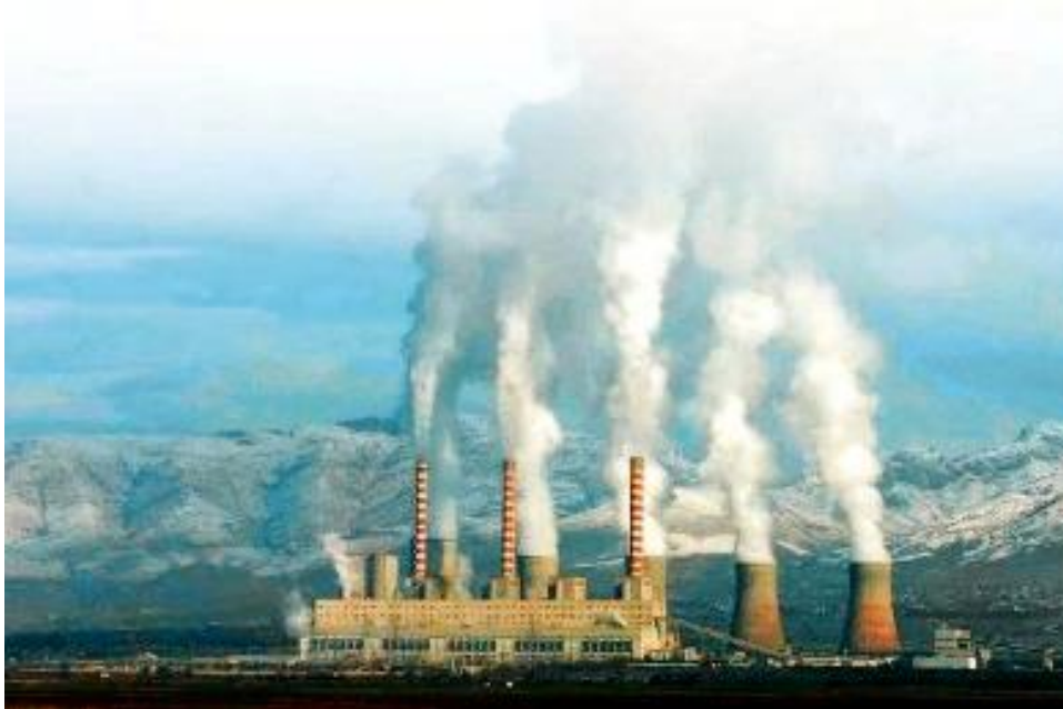
Εικόνα 4.8: Ατμοηλεκτρικός σταθμός Πτολεμαΐδας
