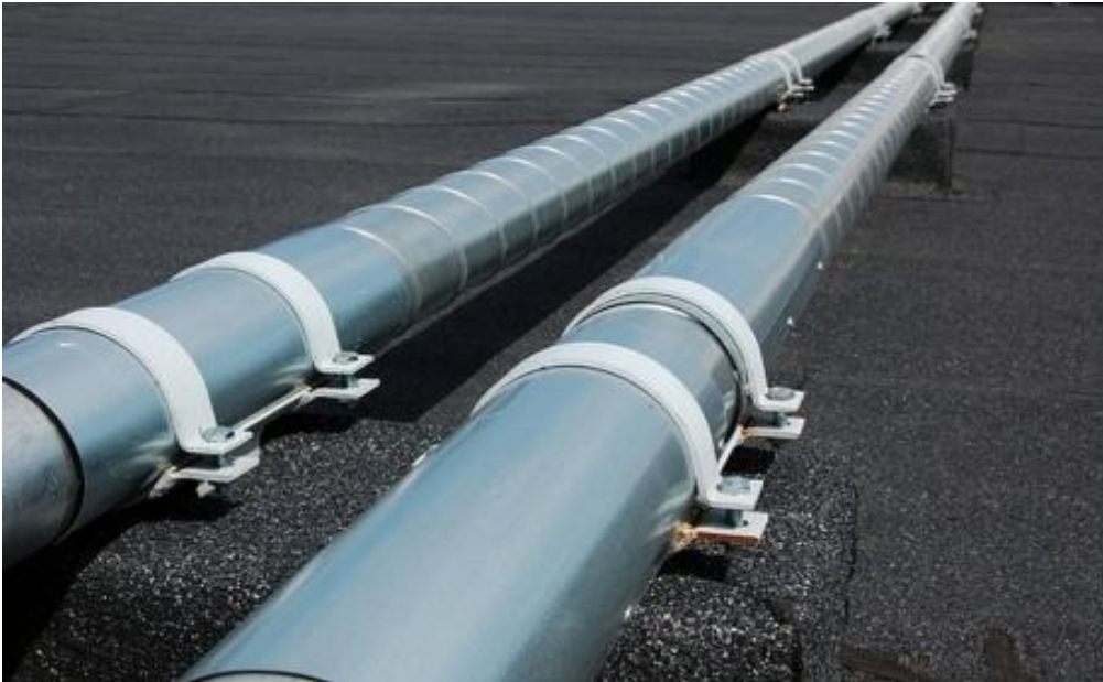
Εικόνα 4.3: Δίκτυο αγωγών τηλεθέρμανσης
