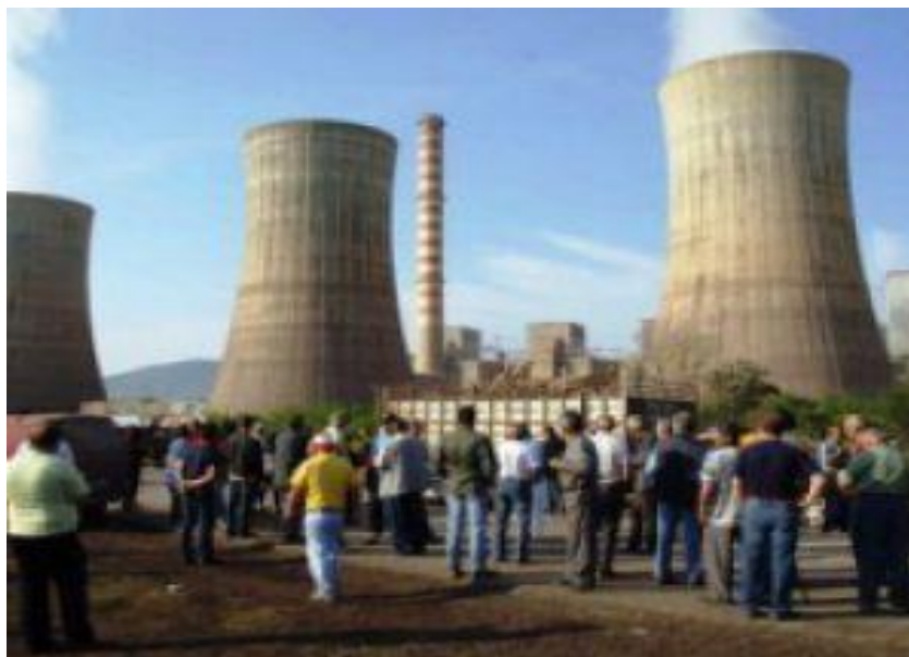
Εικόνα 4.9: Ατμοηλεκτρικός σταθμός Μεγαλόπολης
