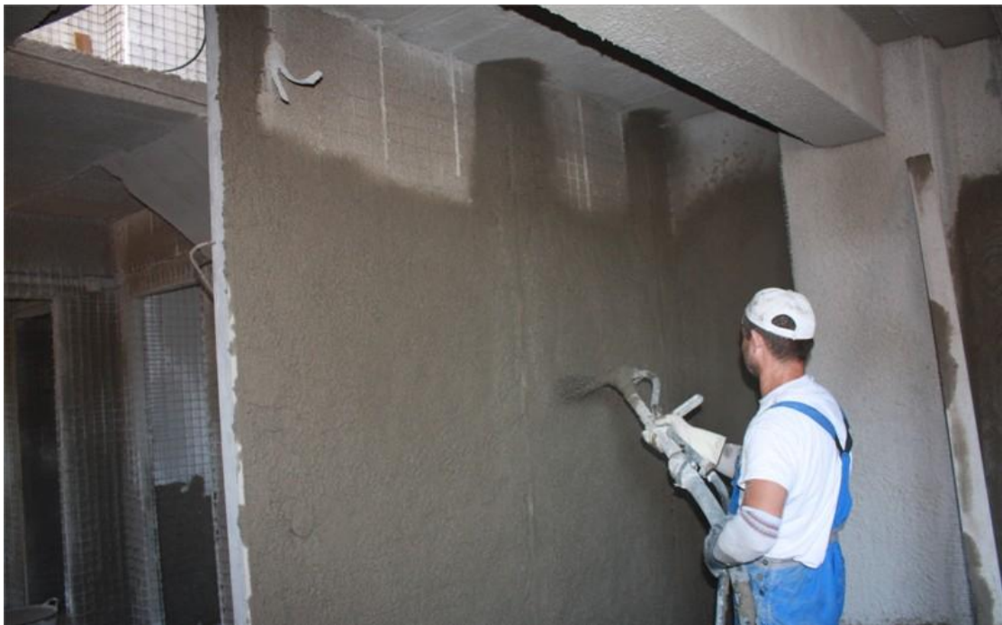
Εικόνα 1.7 : Εκτόξευση ισχυρής τσιμεντοκονίας
