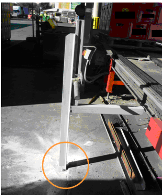
Εικόνα 2.5: Στήριξη στο δάπεδο.
