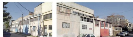
ΥΦΙΣΤΑΜΕΝΑ ΚΤΙΡΙΑ ΟΙΚΟΠΕΔΟΥ ΕΠΙ ΤΗΣ ΟΔΟΥ ΚΟΖΑΝΗΣ
