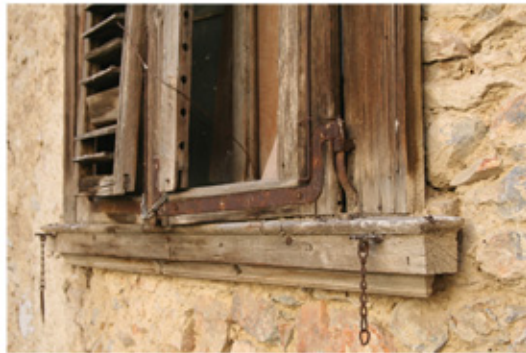
Λεπτομέρεια του παραθύρου εσωτερικά και εξωτερικά, μεταλλικοί σύνδεσμοι στην ένωση των κάθετων στοιχείων του κινητού μέρους του κουφώματος και προσαρμογή στο μντεσά αντίστοιχα
