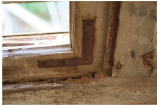
Λεπτομέρεια του παραθύρου εσωτερικά και εξωτερικά, μεταλλικοί σύνδεσμοι στην ένωση των κάθετων στοιχείων του κινητού μέρους του κουφώματος και προσαρμογή στο μντεσά αντίστοιχα
