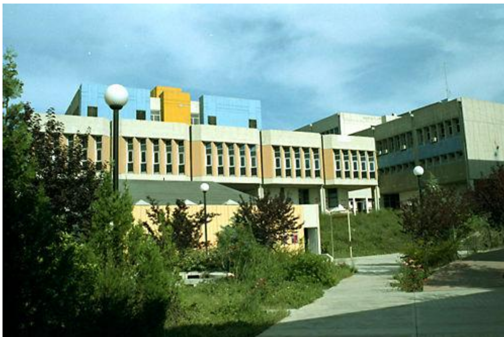
Σχήμα 5.2 : Βορειοδυτική πρόσοψη κτιρίου
