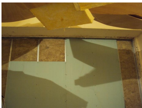
ΕΙΚΟΝΑ 11.4 ΤΡΙΤΟ ΣΤΑΔΙΟ ΚΑΤΑΣΚΕΥΗΣ ΣΤΟ ΕΡΓΑΣΤΗΡΙΟ-ΠΡΟΣΘΗΚΗ ΓΥΨΟΣΑΝΙΔΑΣ
