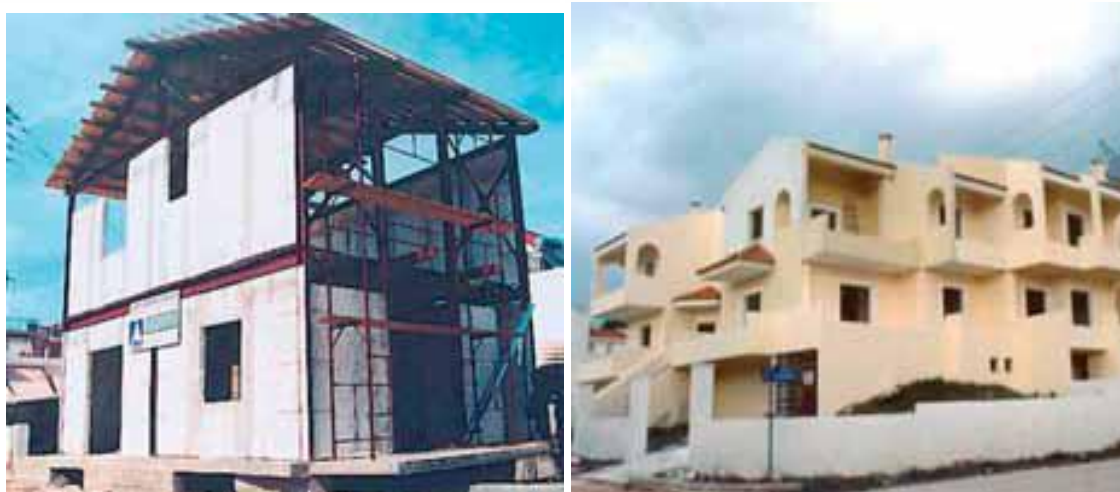
ΕΙΚΟΝΑ 4.11 ΠΡΟΣΟΨΕΙΣ ΜΕΤΑΛΛΙΚΟΥ ΚΤΙΡΙΟΥ ΜΕ ΠΑΝΕΛΑ 3Δ (ΑΠΟ ΕΚΤΟΞΕΥΟΜΕΝΟ ΣΚΥΡΟΔΕΜΑ ΜΕ ΕΝΔΙΑΜΕΣΗ ΘΕΡΜΟΜΟΝΩΣΗ)
