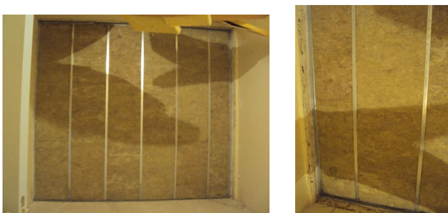
ΕΙΚΟΝΑ 11.3 ΔΕΥΤΕΡΟ ΣΤΑΔΙΟ ΚΑΤΑΣΚΕΥΗΣ ΣΤΟ ΕΡΓΑΣΤΗΡΙΟ
