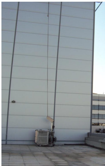
ΕΙΚΟΝΑ 9.3 ΠΕΤΑΣΜΑ ΣΤΗΝ ΚΑΤΑΣΚΕΥΗ
