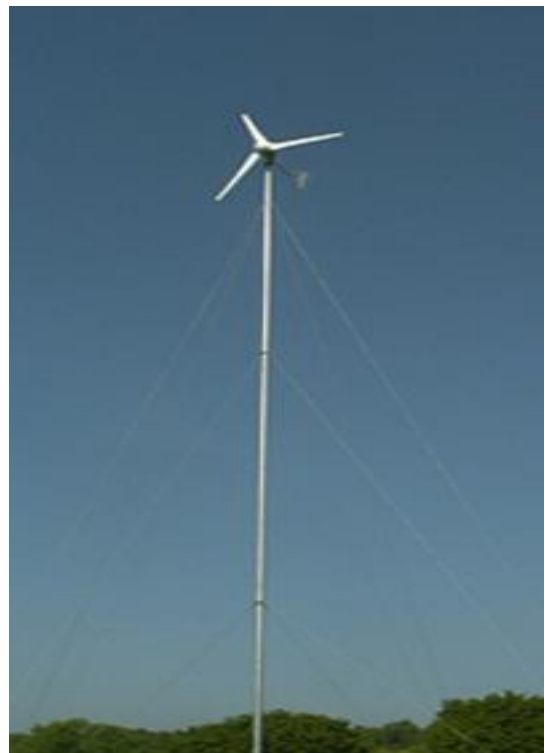
Εικόνα 1.10: Σωληνωτός πύργος που στηρίζεται σε επίτονα
