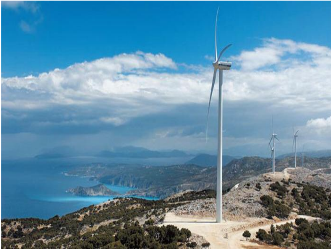
Εικόνα 1.1: Αιολικό Πάρκο στο Ημεροβίγλι της Κεφαλονιάς
