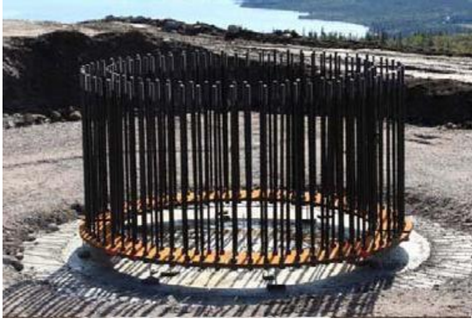
Εικόνα 1.6: Μορφή θεμελίωσης με αγκύρια υψηλής αντοχής
