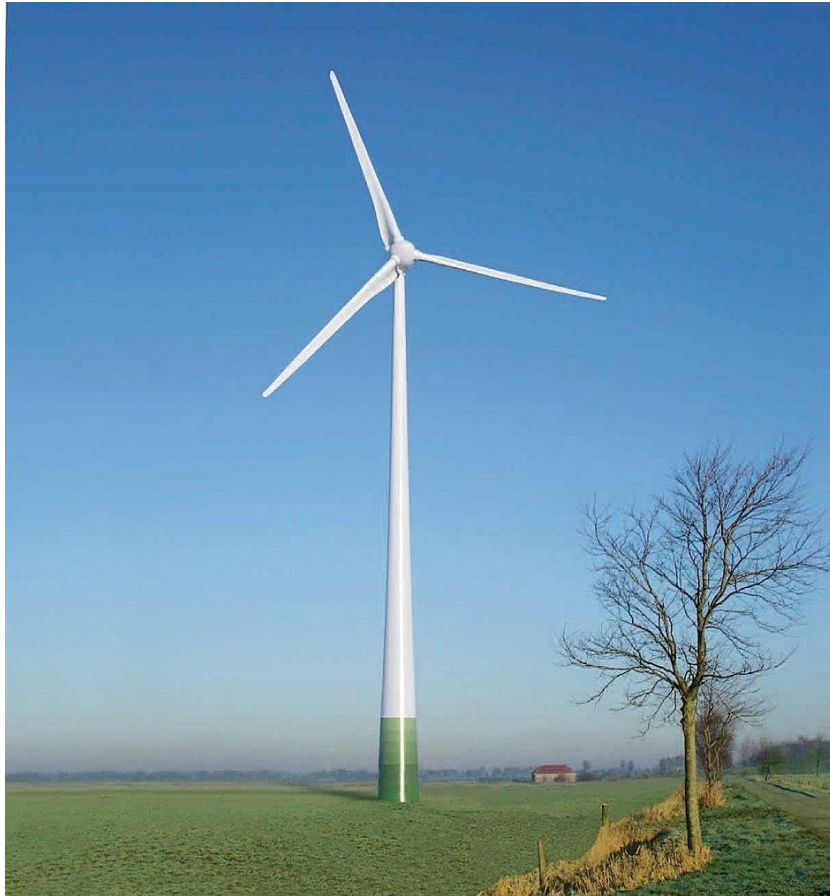
Εικόνα 1.3: Ανεμογεννήτρια οριζόντιου άξονα
