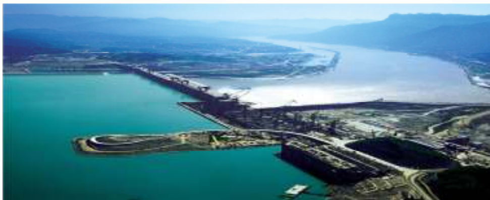
Εικόνα 3-7: Το μεγαλύτερο υδροηλεκτρικό πάρκο στον κόσμο με ισχύ 18,460 MW (υπό κατασκευή στην Κίνα)
