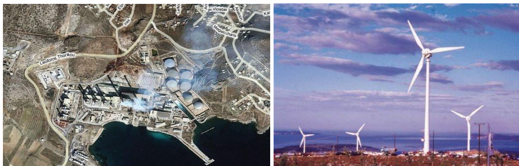
Εικόνα 9: Εργοστάσιο παραγωγής ηλεκτρικού ρεύματος και ανεμογεννήτριες στην περιοχή
