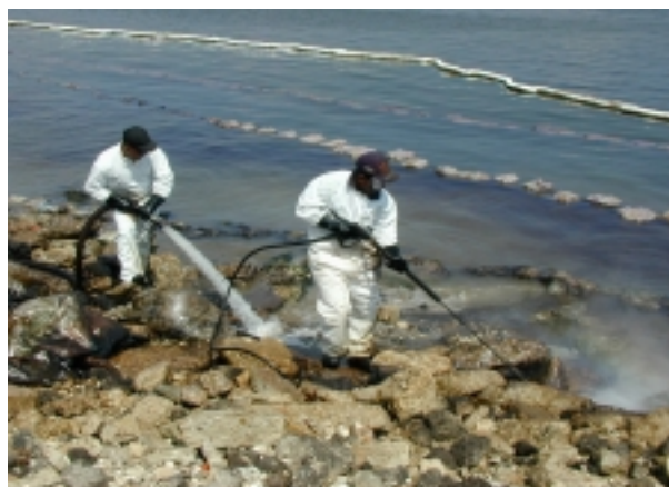
Φωτό 2. Πλύσιμο υψηλής πιέσεως σε βραχώδη περιοχή
