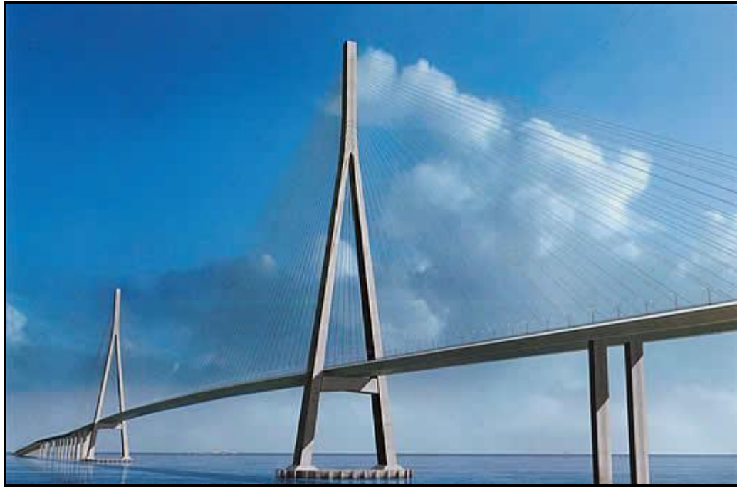
Σχήμα 1.39 Γέφυρα Sutong – Πυλώνες σχήματος ανεστραμμένου Υ
