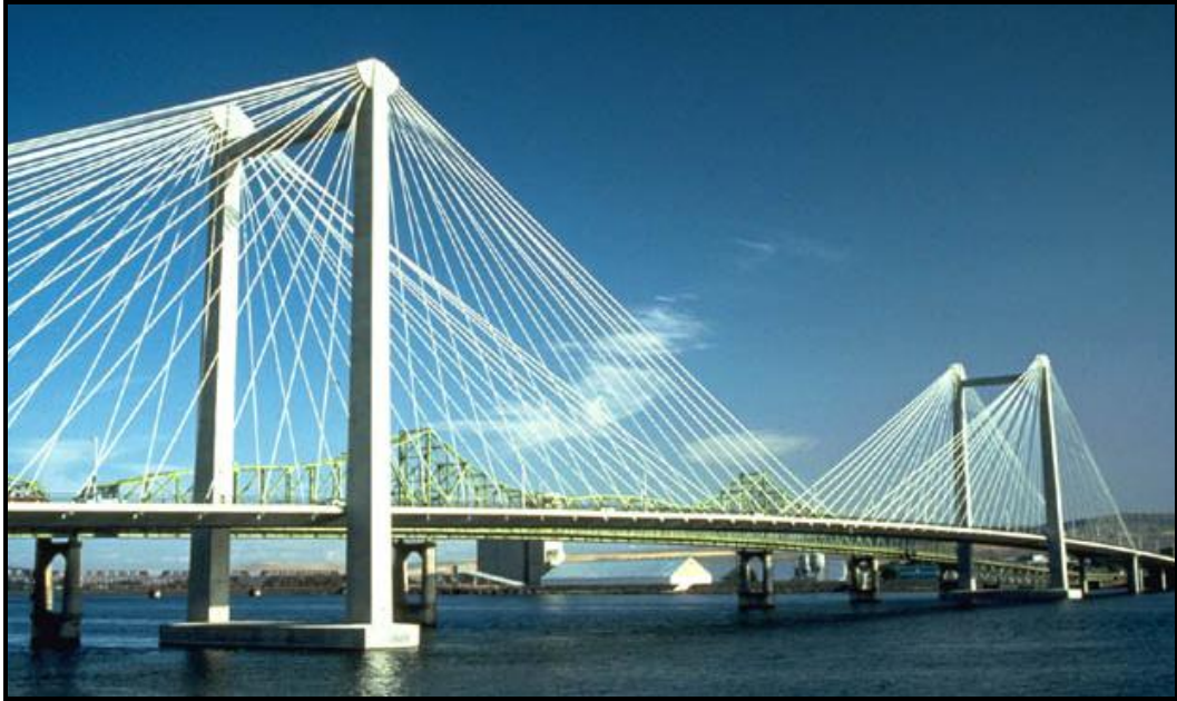
Σχήμα 1.37 Γέφυρα Pasco – Kennewick – Πυλώνες σχήματος Π
