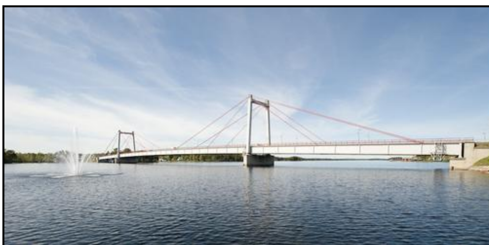
Σχήμα 1.21 Γέφυρα George Stromsund (1956)
