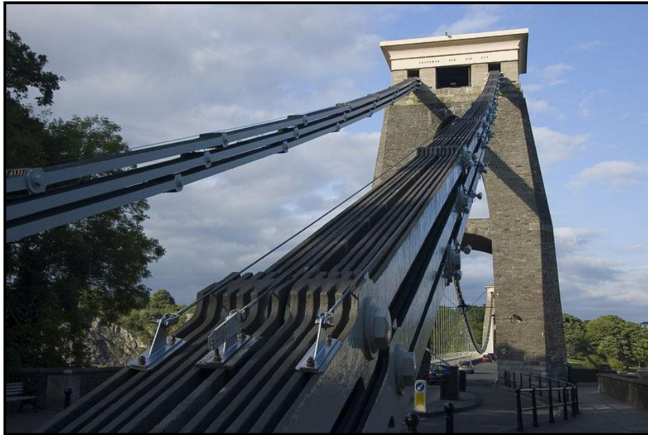
Σχήμα 1.11 Καλώδια γέφυρας Clifton μορφής αλυσίδας
