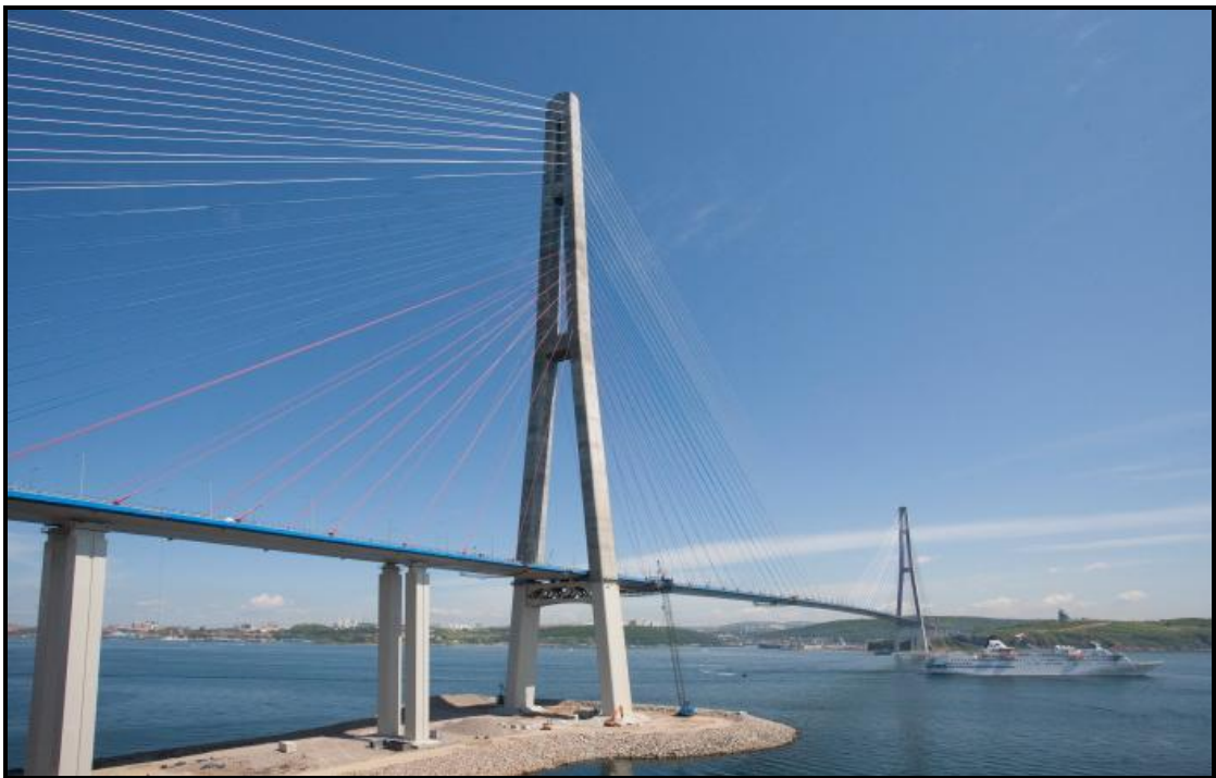
Σχήμα 1.38 Γέφυρα Bridge to Russky Island – Πυλώνες σχήματος Α
