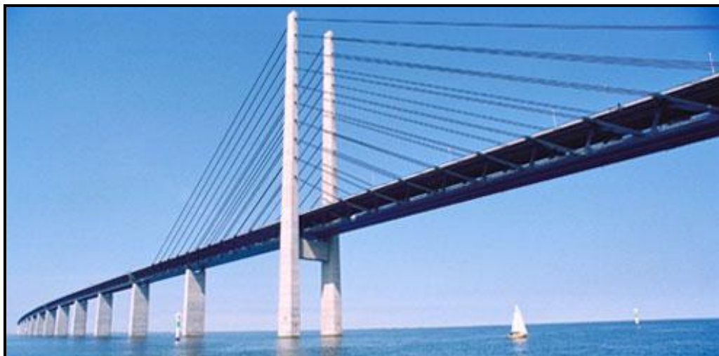
Σχήμα 1.36 Γέφυρα Oresund – Πυλώνας σχήματος Η
