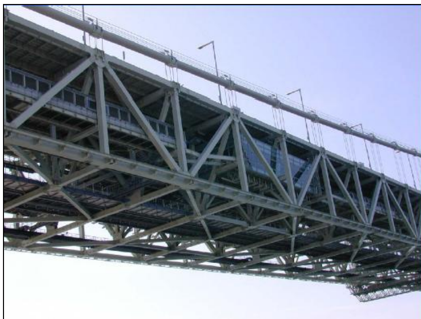
Σχήμα 1.49 Γέφυρα Akashi – Kaikyo – Χρήση κύριων δοκών έδρασης μορφής δικτυώματος
