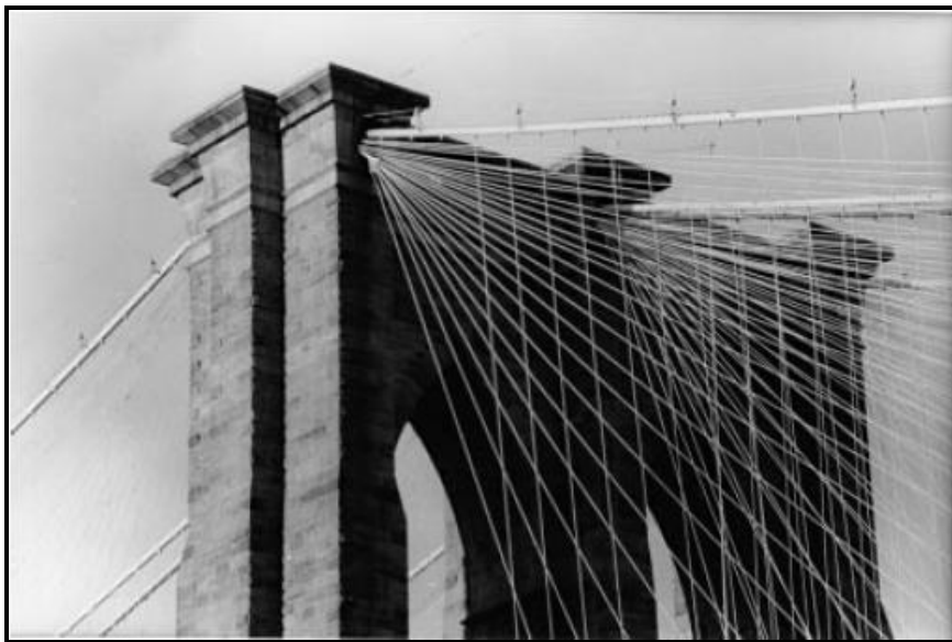
Σχήμα 1.15 Σύστημα Καλωδίωσης γέφυρας Brooklyn
