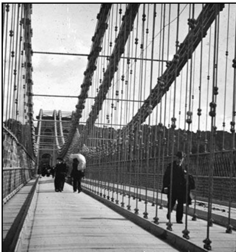
Σχήμα 1.8 Το σύστημα καλωδίωσης της γέφυρας Menai (1826)
