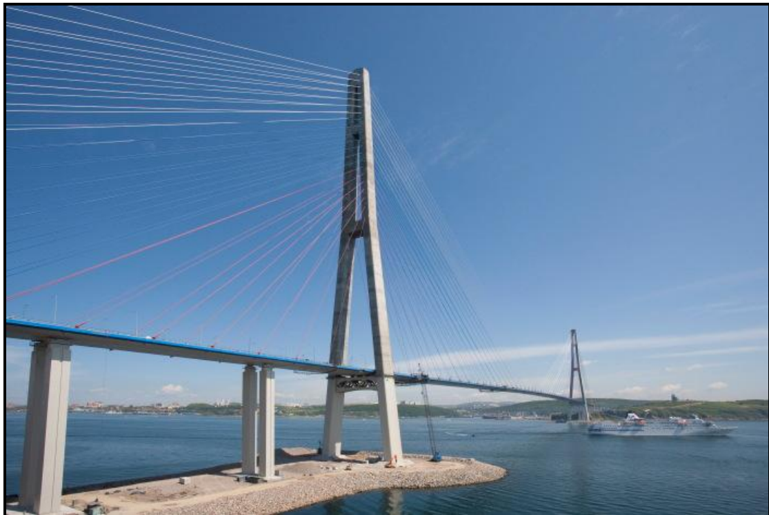
Σχήμα 1.30 Γέφυρα Bridge to Russky Island (2012)
