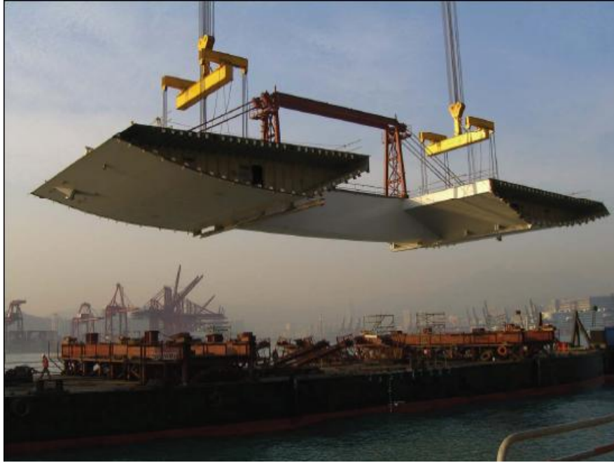
Σχήμα 1.46 Μεταλλικό κατάστρωμα γέφυρας Stonecutters
