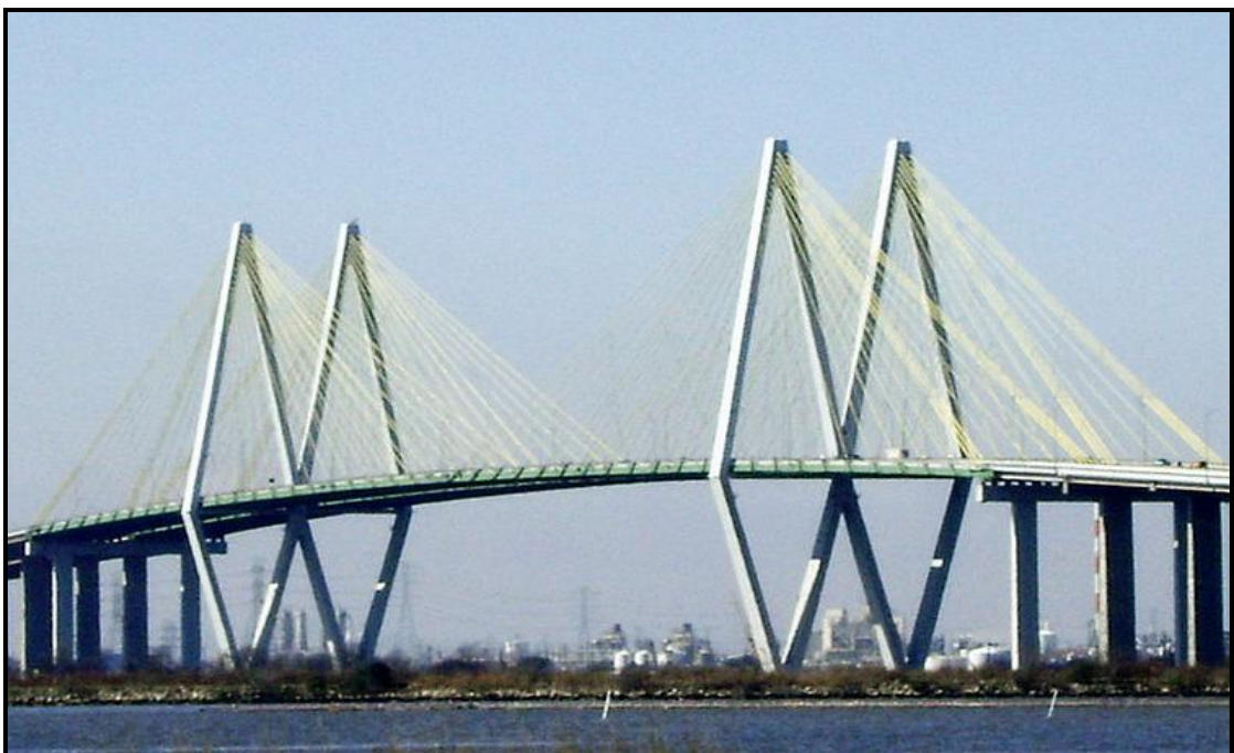
Σχήμα 1.40 Γέφυρα Baytown – Πυλώνες σχήματος διαμαντιού
