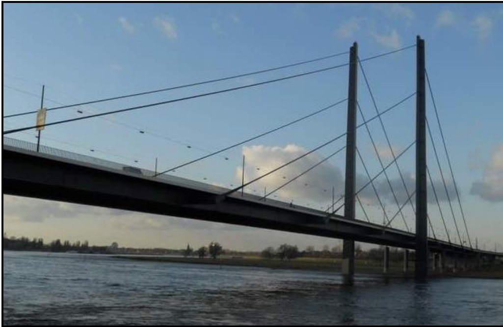
Σχήμα 1.35 Γέφυρα Theodor Heuss (Düsseldorf) – Πυλώνας αποτελούμενος από δύο ανεξάρτητους προβόλους
