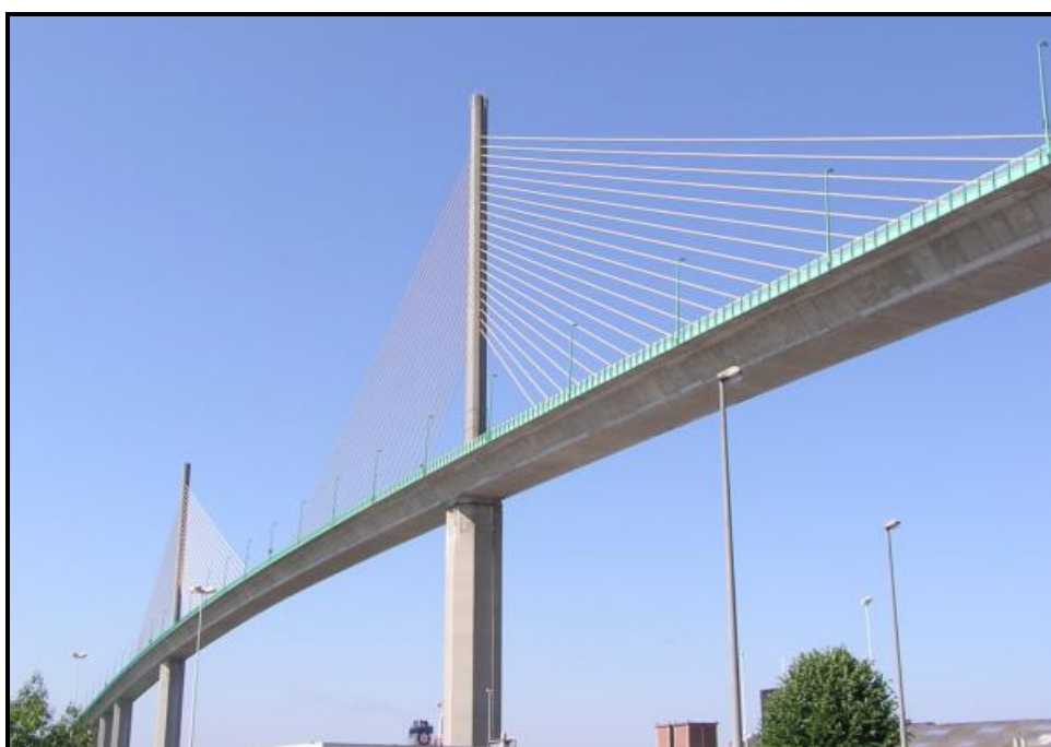
Σχήμα 1.34 Γέφυρα Brotonne – Πυλώνας μορφής προβόλου
