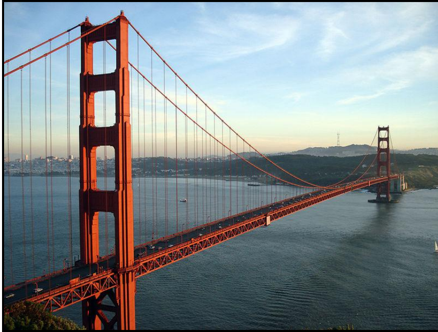
Σχήμα 1.19 Γέφυρα Golden Gate (1937)
