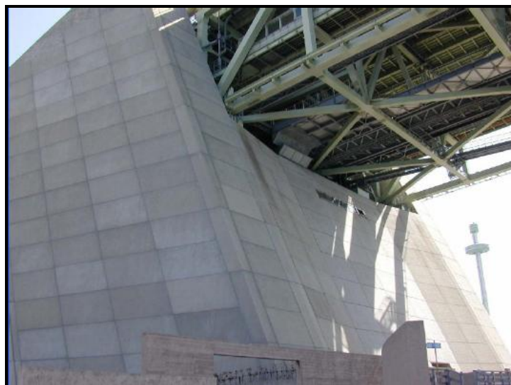
Σχήμα 1.53 Γέφυρα Akashi – Kaikyo : Βάθρο αγκύρωσης κυρίου καλωδίου διαστάσεων 84m x 63m x 52 m
