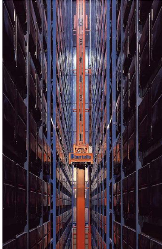
Εικόνα 2.1 Automatic Storage & Retrieval Systems
