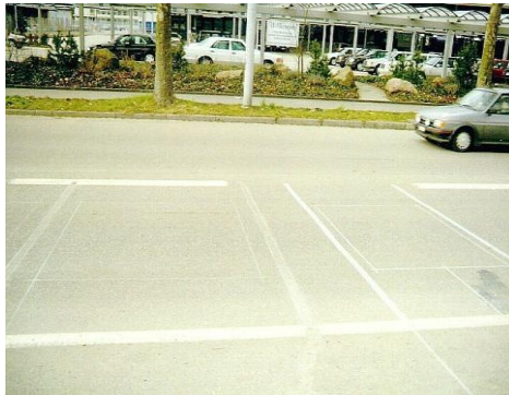
Εικόνα 3.5 Πιεζοηλεκτρικό σύστημα WIM
