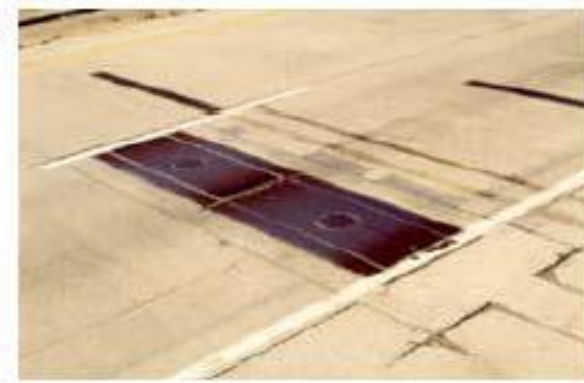
Εικόνα 3.6 WIM με κυψέλες φορτίου.
