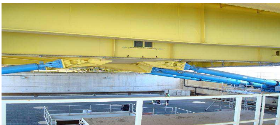
Οι αναρτήρες του καταστρώματος
