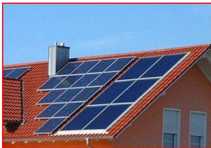
Εικ. 4.9 Φωτοβολταϊκά σε στέγη
