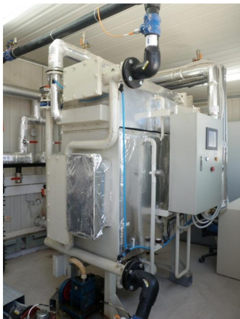
Εικόνα 1.2.6 Ψύκτης Εγκατάστασης
