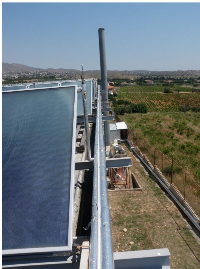
Εικόνα 1.1.2 Αγωγοί Κρύου-Ζεστού Νερού απο/προς την Δεξαμενή.
