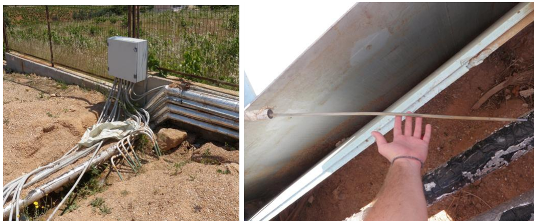
Εικόνα 1.3.1 TS2251 , Πίνακας Δεξαμενής
