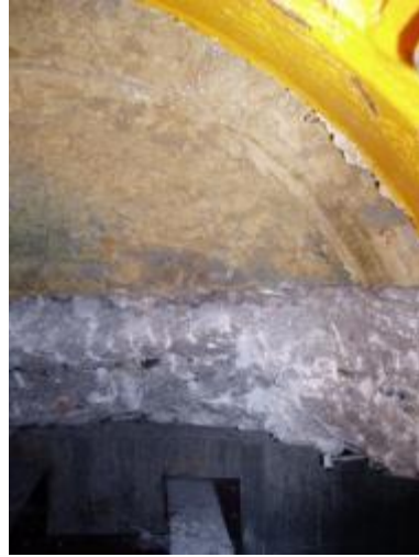
Εικόνα 4. 20: Ανομοιογενές μέτωπο εκσκαφής πάνω από τον πλακοσκεπή αγωγό (9).
