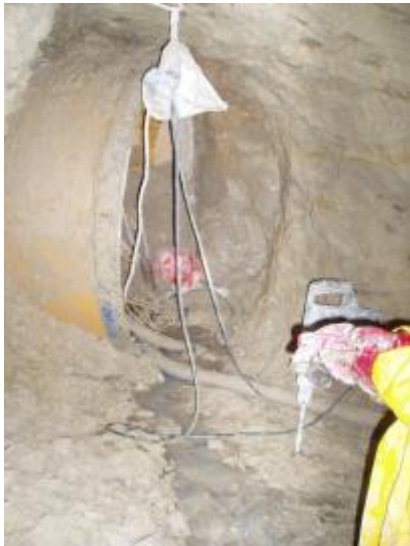
Εικόνα 4. 39: Αποκάλυψη του μηχανήματος εκσκαφής της σήραγγα (9).
