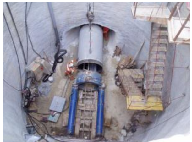
Εικόνα 1. 38: Κύριος σταθμός ώθησης σε συστολή των εμβόλων (9).
