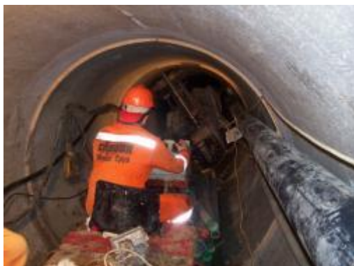
Εικόνα 3. 27: Διάτρηση αποστραγγιστικών γεωτρήσεων (12)
