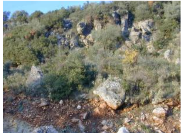
Εικόνα 3. 11: Έντονης ανομοιομορφίας υλικά καταπτώσεων (RFrg), ογκόλιθοι ασβεστόλιθων και αργιλοχαλικώδη υλικά
