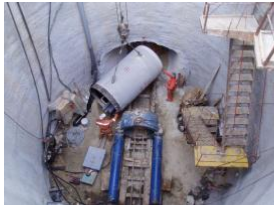
Εικόνα 4. 16: Σύστημα προώθησης σωλήνων σε συστολή διαδικασία προσθήκης νέου σωλήνα (9).
