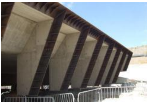
Εικόνα 1. 58: Ασπίδα –Διαμερισματοποίησης μετώπου Box Jacking (15).
