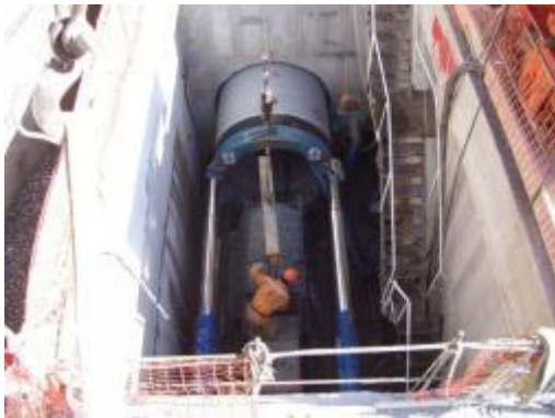
Εικόνα 3. 20: Πρόσδεση κουβά στο σύστημα ανέλκυσης (12)
