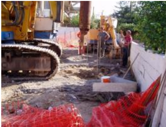
Εικόνα 4. 35: Στήσιμο του γεωτρόπανου (9).
