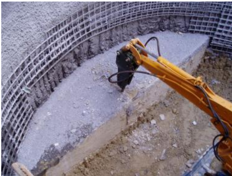
Εικόνα 4. 27: Καθαίρεση της οροφής και του τοιχίου του πλακοσκεπούς αγωγού (9).
