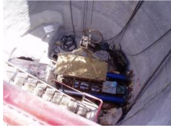
Εικόνα 4. 12: Ανέλκυση του φορτωμένου κάδου (9).
