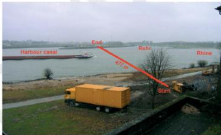
Εικόνα 1. 7: Διάτρηση HDD κάτω από διάυλο ναυσιπλοΐας (3)
