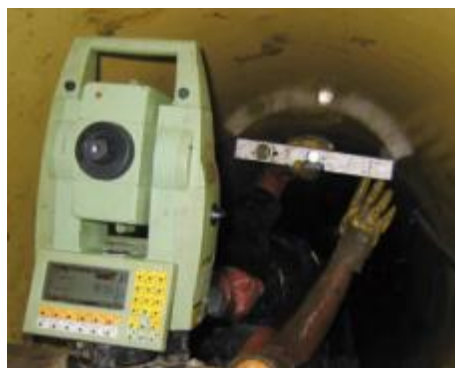
Εικόνα 1. 31: Διάταξη καθοδήγησης με ταχύμετρο λέιζερ εντός του σωλήνα
