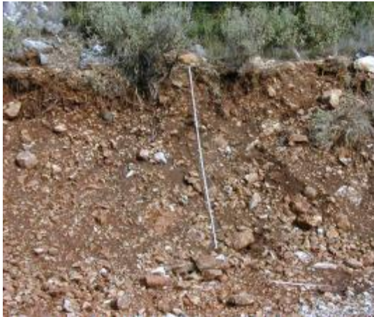
Εικόνα 3. 10: Αργιλοχαλικώδεις φάσεις κορημάτων (SCgc) και υλικών καταπτώσεων (RFrg) περί τη Χ.Θ. 26+100.
