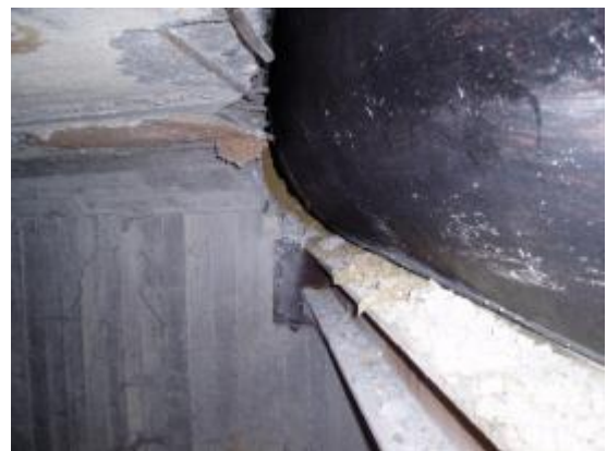
Εικόνα 4. 19: Σωλήνες πάνω από τον πλακοσκεπή αγωγό (9).
