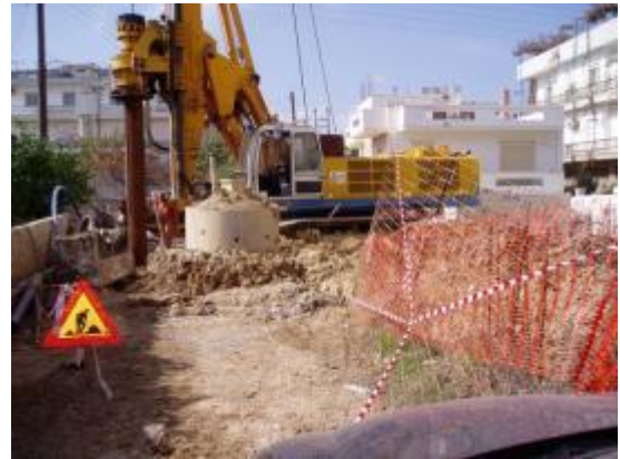
Εικόνα 4. 36: Εργασία κατασκευής του φρεατίου εξόδου (9).
