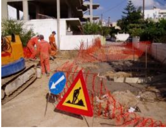
Εικόνα 4. 33: Κατασκευή κεφαλόδεσμου στο φρέαρ εξόδου (9).
