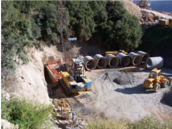
Εικόνα 3. 32: Ανάπτυξη εργοταξίου στη περιοχή του φρεατίου εργασίας Φ1 (12).
