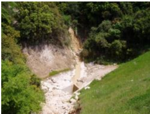
Εικόνα 3. 30: Αρχική όψη του χώρου κατασκευής του φρεατίου αρχής Φ1 (12).
