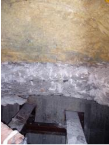
Εικόνα 4. 20: Ανομοιογενές μέτωπο εκσκαφής πάνω από τον πλακοσκεπή αγωγό (9).
