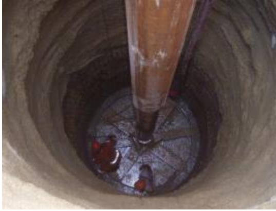
Εικόνα 4. 37: Τοποθέτηση διπλού πλέγματος στην παρειά του φρεατίου (9).
