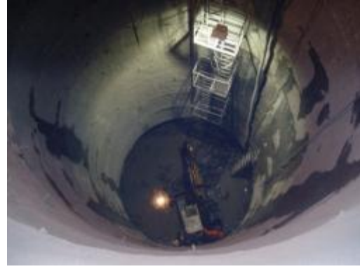
Εικόνα 3. 34: Εκσκαφή φρεατίου Φ1 (12)
