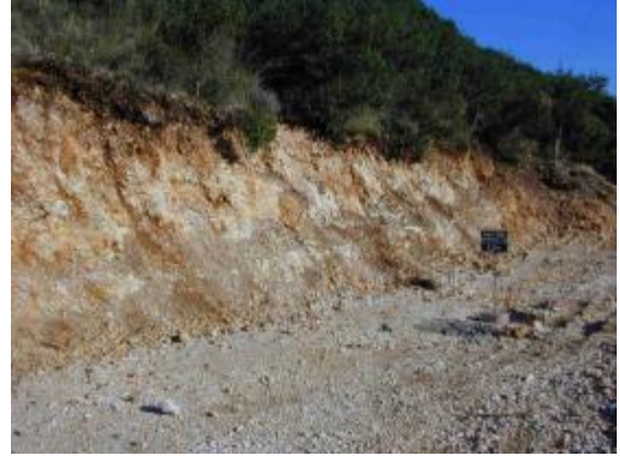
Εικόνα 3. 7: Εμφάνιση των έντονα κατακερματισμένων ασβεστόλιθων (ke.br) περί τη Χ.Θ. 24+600 (25)
