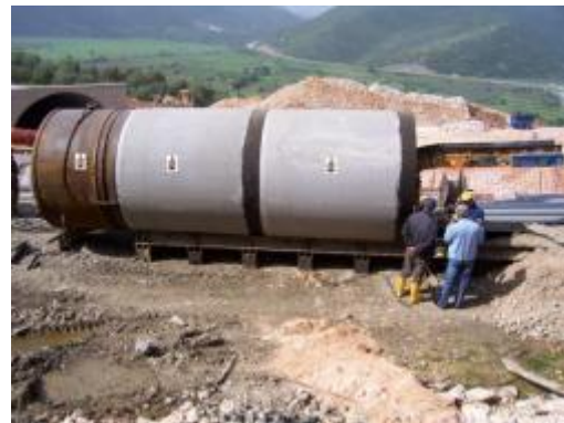
Εικόνα 3. 16: Πλάγια όψη του τοποθετημένου εντός δύο σωλήνων μηχανήματος εκσκαφής (12).
