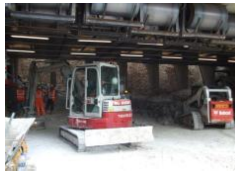
Εικόνα 1. 59: Εκσκαφή Box Jacking (15).
