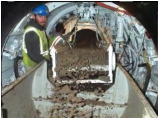
Εικόνα 1. 34: Φόρτωση του κάδου μεταφοράς.
