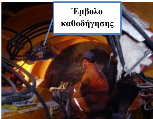
Εικόνα 4. 9: Έμβολο καθοδήγησης της κεφαλής (9).
