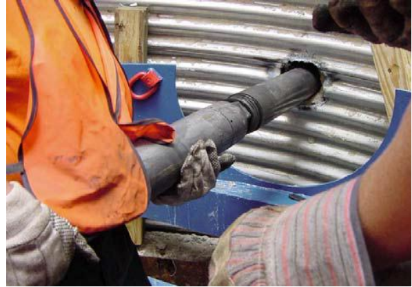
Εικόνα 1. 10: Άφιξη πιλοτικού στελέχους στο φρεάτιο άφιξης.
