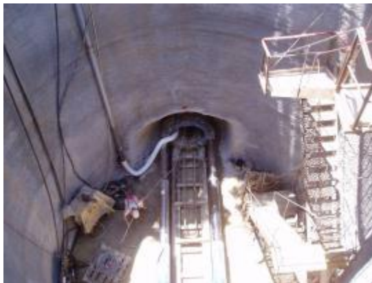
Εικόνα 4. 15: Σύστημα προώθησης σωλήνων σε πλήρη έκταση (9).
