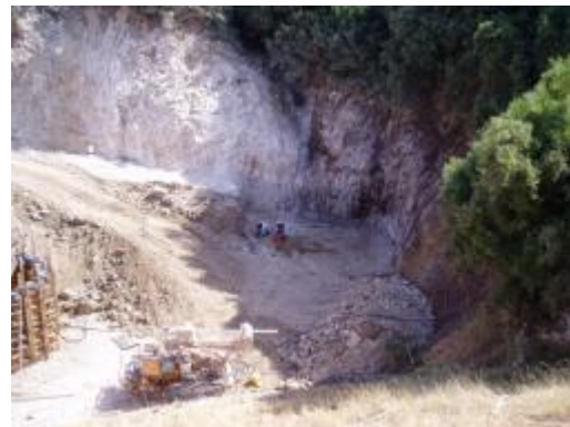
Εικόνα 3. 31: Εκσκαφές για την κατασκευή της του φρεατίου αρχής Φ1 (12).
