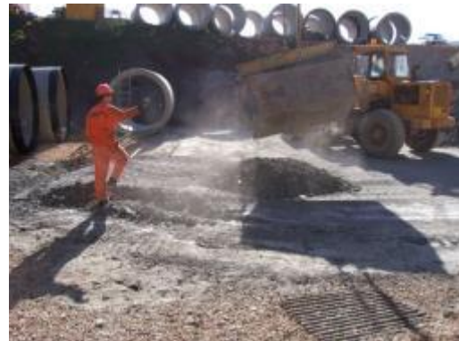
Εικόνα 3. 21: Εκκένωση του κουβά στην επιφάνεια (12)
