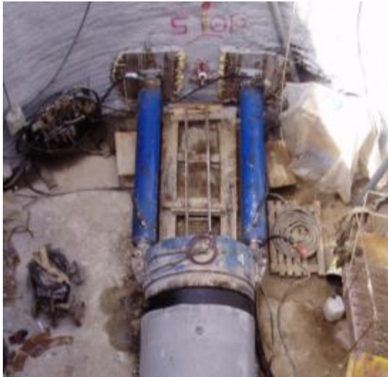
Εικόνα 4. 13: Σύστημα προώθησης σωλήνων (9).
