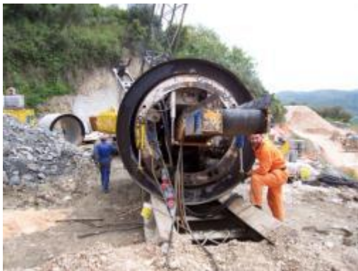
Εικόνα 3. 15: Πίσω όψη του τοποθετημένου εντός του σωλήνα μηχανήματος εκσκαφής (12)
