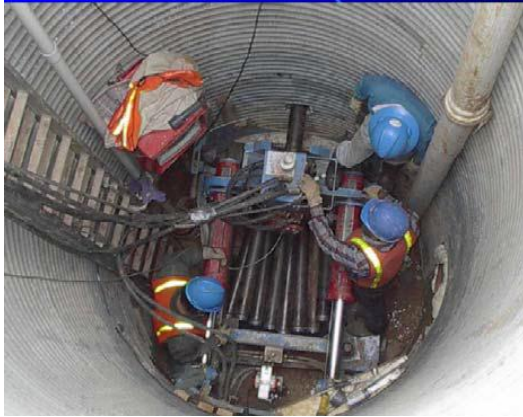
Εικόνα 1. 9: Ωθηση πιλοτικών στελεχών από το φρεάτιο εργασίας.
