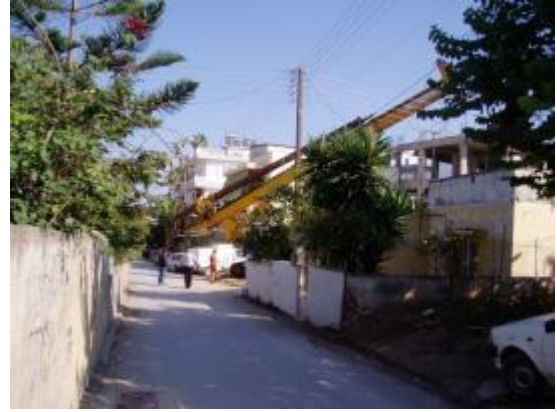
Εικόνα 4. 34: Εγκατάσταση του γεωτρόπανου (9).
