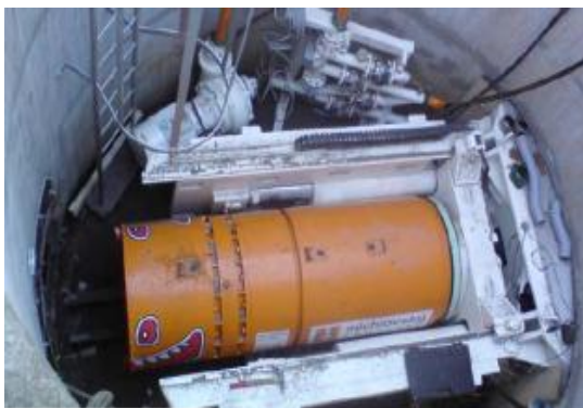
Εικόνα 1. 39: Κύριος σταθμός ώθησης με παράλληλη διάταξη εμβόλων και σωλήνα.
