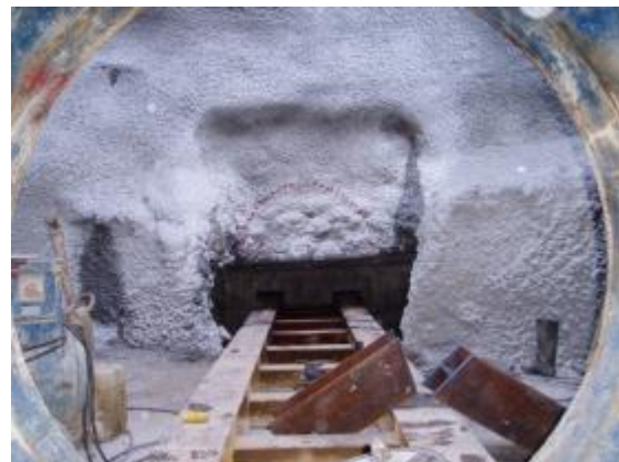
Εικόνα 4. 31: Η γεφύρωση του πλακοσκεπούς αγωγού έχει τελειώσει (9).
