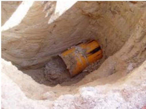
Εικόνα 4. 21: Έξοδος του μηχανήματος σε σημείο εξόδου κατ' ευθείαν στο έδαφος (9).
