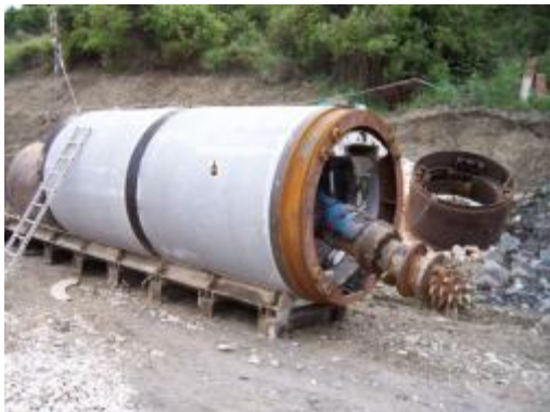
Εικόνα 3. 13: Πλαγία όψη του τοποθετημένου εντός του σωλήνα, μηχανήματος εκσκαφής της σήραγγας χωρίς την εμπρός κεφαλή (12)
