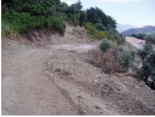
Εικόνα 3. 33: Ο χώρος για την κατασκευή του φρεατίου Φ2 (12)
