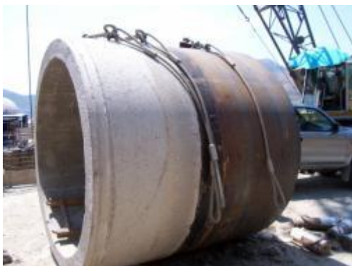
Εικόνα 3. 23: Ενδιάμεσος σταθμός ώθησης (12)
