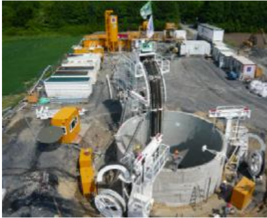
Εικόνα 1. 53: Διάταξη σύστημα εκσκαφής φρεατίου VSM, (13)
