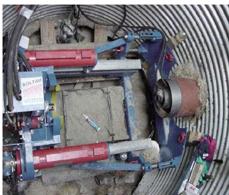
Εικόνα 1. 16: Τοποθέτηση σωλήνωσης (Casing) και Auger κατά τη διεύρυνση της πιλοτικής διάτρησης.
