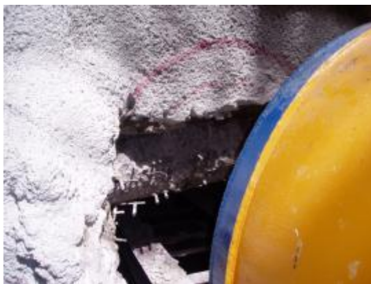
Εικόνα 4. 18: Μέτωπο εκσκαφής πάνω από τον πλακοσκεπή αγωγό (9)
