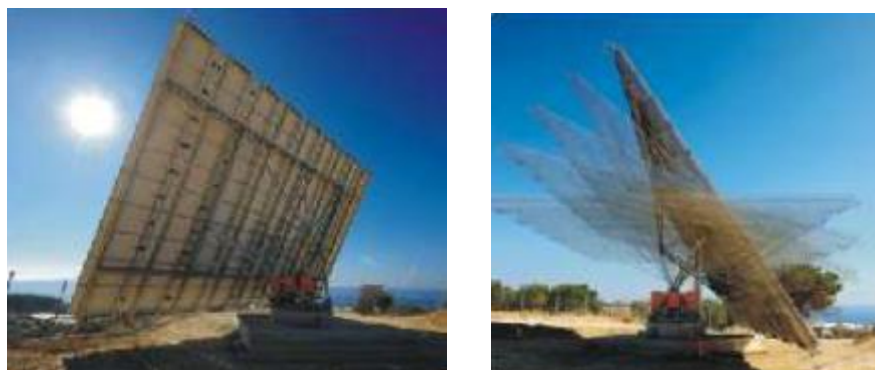
Σχήμα 5.2.1 :Πίσω όψη του συστήματος ιχνηλάτησης και οι κινήσεις που εκτελεί.
