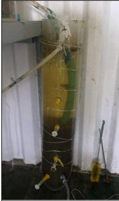
Εικόνα 3.12: Δεξαμενή Τελικής Καθίζησης (ΔTK).
