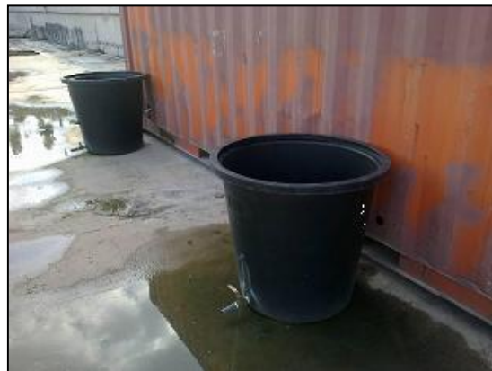
Εικόνα 3.14: Δεξαμενή Συγκέντρωσης Εκροής
