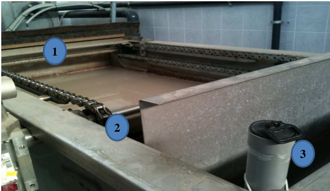
Σχήμα 14: Επιφανειακό ζέστρο μονάδας DAF βιομηχανικής μονάδας (1) Επιφανειακό ζέστρο , (2) κανάλι ξαφρισμάτων , (3) λύματα για τροφοδοσία προς αερόβια επεξεργασία- MBR
