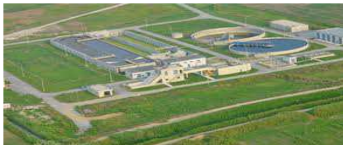
Σχήμα 2: Άποψη ολοκληρωμένης μονάδας βιολογικού καθαρισμού
