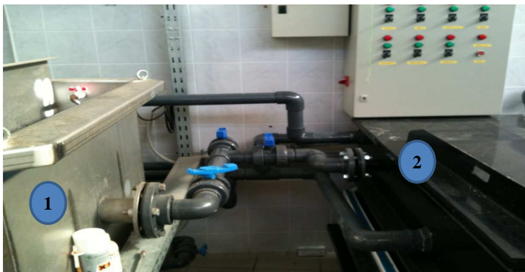
Σχήμα 16: Βιομηχανική διάταξη διασύνδεσης μονάδας DAF με δεξαμενή αερισμού- απονιτροποίησης
