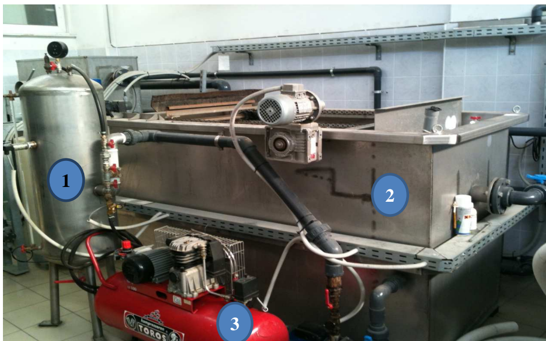
Σχήμα 13: Μονάδα DAF βιομηχανικής μονάδας επεξεργασίας λυμάτων ζαχαροπλαστικής, με το πιεστικό.
