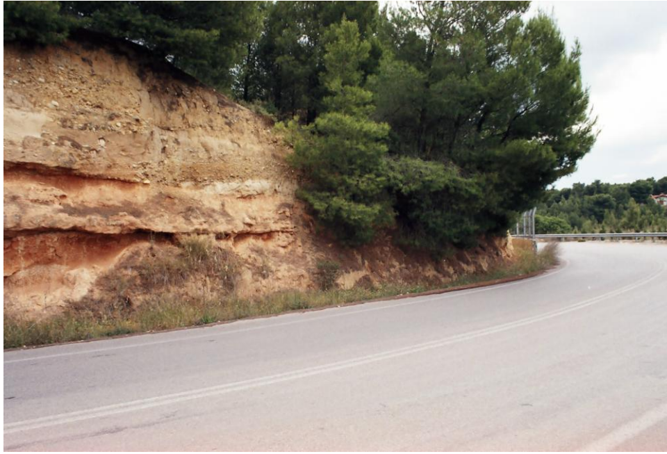
Φωτογραφία 5.8. Το χαμηλότερο τμήμα του πρανούς δομείται από αργιλοϊλυώδη υλικά ερυθρού χρώματος με ενστρώσεις άμμων και μικροκροκαλοπαγών ημισυνεκτικής δομής (ορίζοντας 1). Το υψηλότερο τμήμα του πρανούς, δομείται από εναλλαγές άμμων και κροκαλοπαγών, ημισυνεκτικής δομής (ορίζοντας 2).
