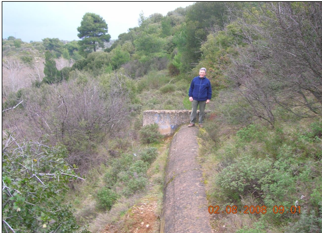
Φωτογραφία 8.4. Άποψη του υδραγωγείου (κλειστό σκυφοειδούς σχήματος) στο πρηνές του Κηφισσού πλησίον της προέκτασης της οδού Τροιζηνίας.
