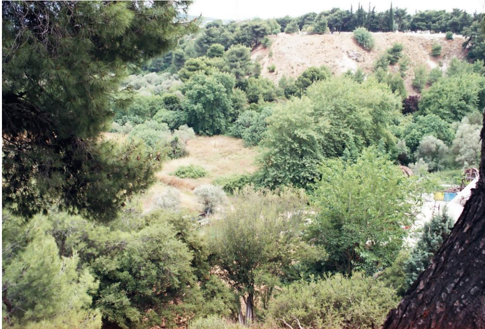
Φωτογραφία 5.2. Θέση φράγματος ΦΚ-4. Γενική άποψη του αριστερού αντερείσματος.
