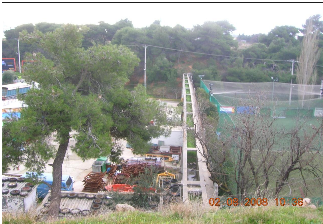
Φωτογραφία 8.5. Άποψη του υπερυψωμένου υδραγωγείου πάνω από την οδό Δεκελείας
